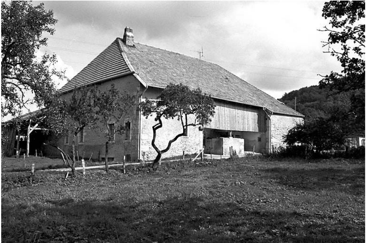
Façade postérieure et face latérale gauche.
