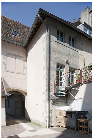
Façade postérieure du logis principal, partie droite. Phot. Jérôme Mongreville IVR43_20112500120NUC4A
