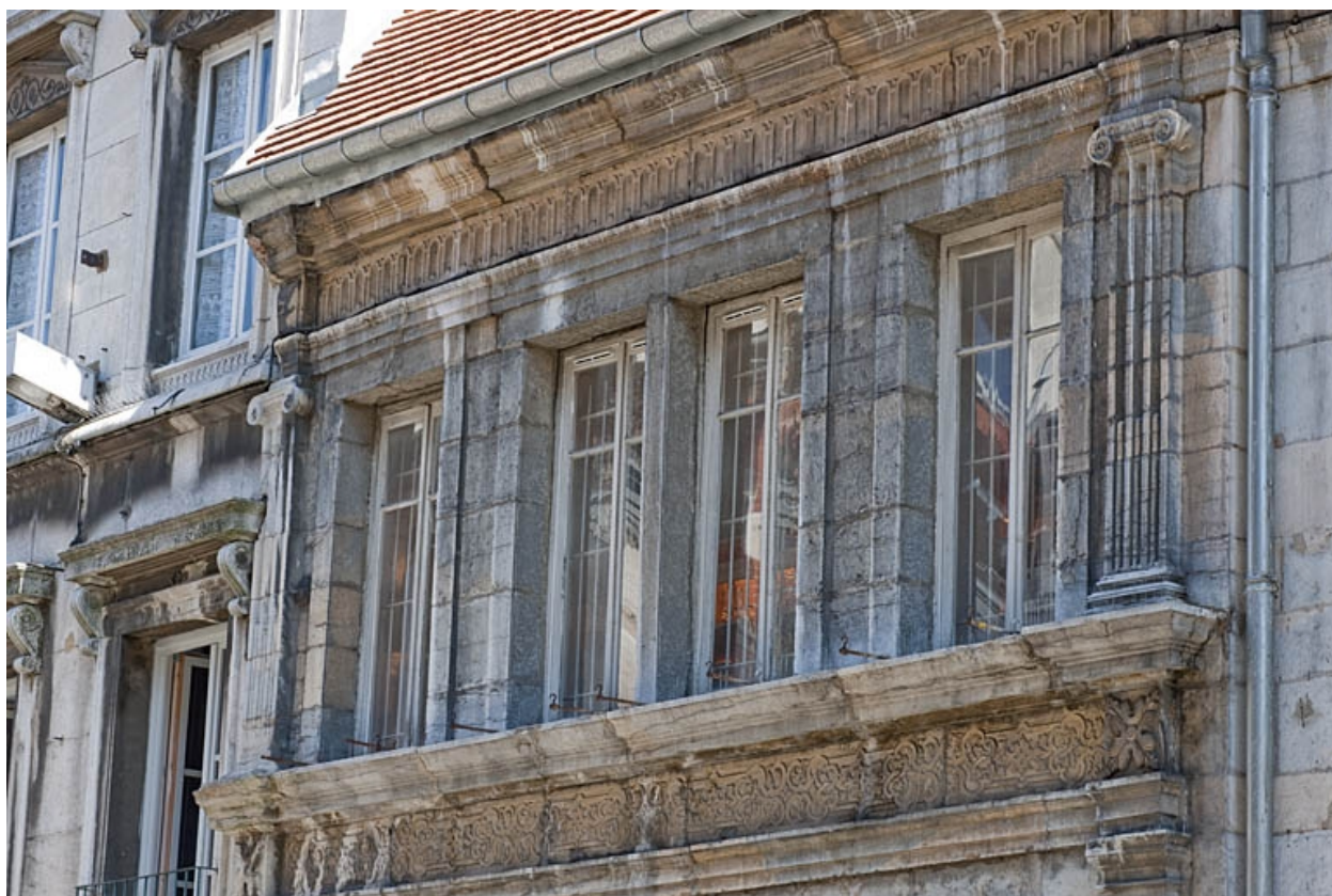
Façade sur rue : premier étage, partie gauche.
