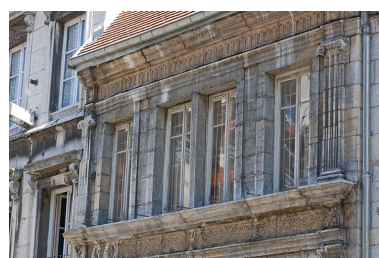
Façade sur rue : premier étage, partie gauche. Phot. Jérôme Mongreville IVR43_20112500130NUC4A
