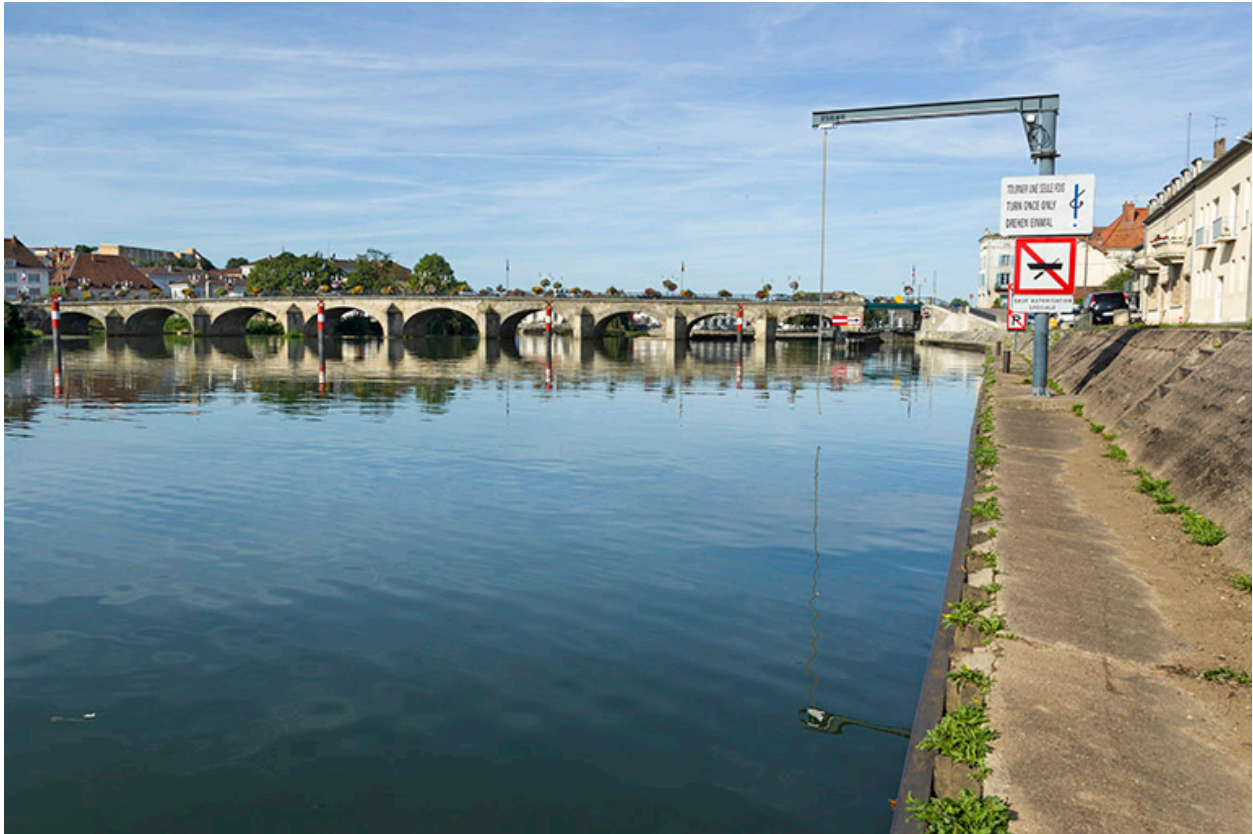
Vue générale du pont et du site d'écluse.
