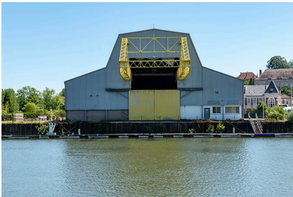
Ancien hangar transformé en société de location de bateaux.
