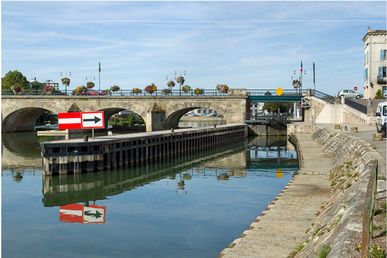
L'écluse, vue depuis l'amont.
