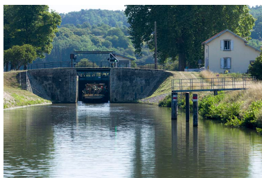
Le site d'écluse depuis l'aval. Phot. Sonia Dourlot IVR43_20157000733NUC2A
