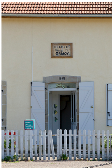
Porte d'entrée avec sa plaque signalétique. Phot. Sonia Dourlot IVR43_20157000728NUC2A
