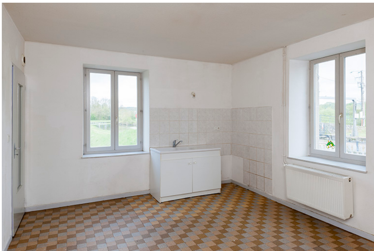
Rez-de-chaussée, cuisine de la maison d'éclusier.
