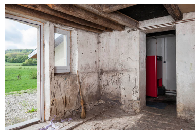
Cave en déblai. Phot. Jérôme Mongreville IVR43_20167000300NUC4A
