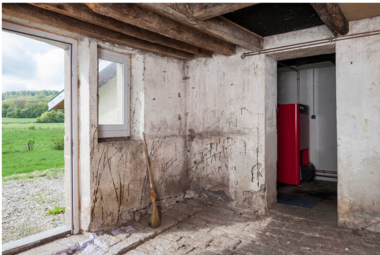
Cave en déblai.
