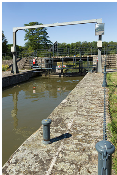
Vue sur un bajoyer et les portes en arrière plan. Phot. Sonia Dourlot IVR43_20157000730NUC2A
