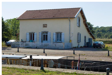
La maison d'éclusier. Phot. Sonia Dourlot IVR43_20157000727NUC2A
