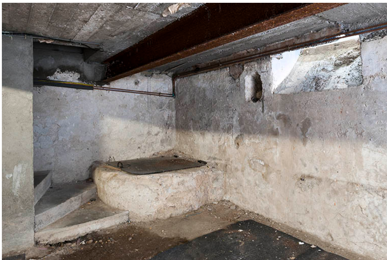
Cave comprenant le puits.
