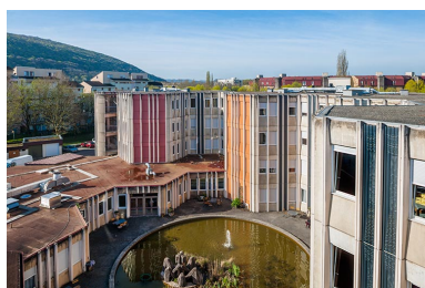
bassin : vue d'ensemble de l'œuvre d'Annie Bleu. Phot. Jérôme Mongreville IVR43_20142500344NUC4A
