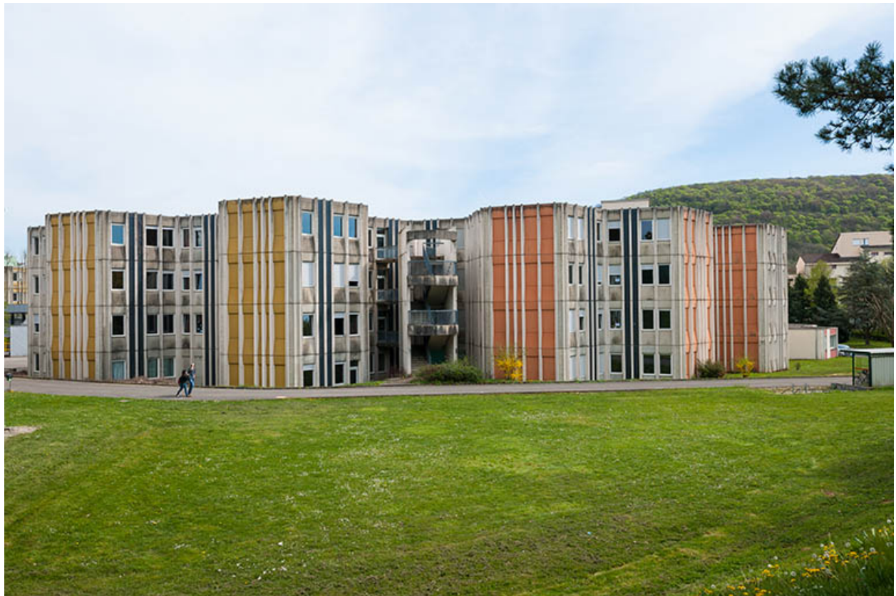
Vue d'ensemble des façades postérieures de l'internat.
