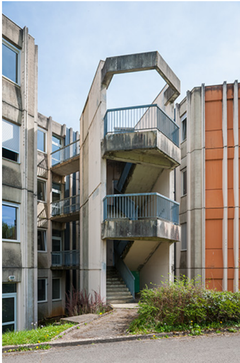
Détail de l'escalier extérieur de l'internat.
