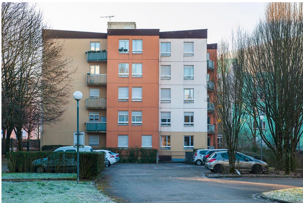
Les logements : façade nord-ouest.
