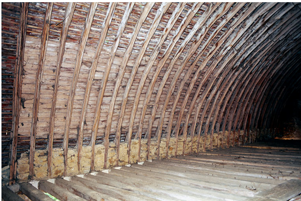
Charpente du séchoir.
