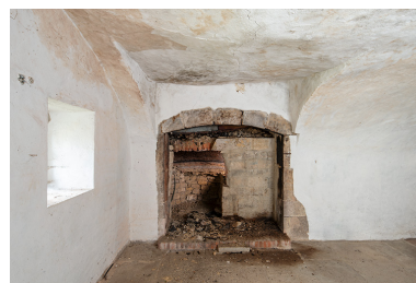
Le four à pain du logis du corps de ferme. Phot. Nicolas Waltefaugle IVR26_20258900202NUC4A
