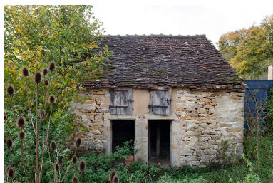
Le toit à porcs. Phot. Nicolas Waltefaugle IVR26_20258900168NUC4A
