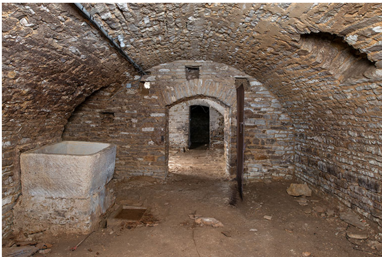
La cave située sous le cuvage, au sud.
