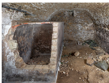
Cave située sous le logis du corps de ferme, avec cuve de vinification. Phot. Nicolas Waltefaugle IVR26_20258900183NUC4A
