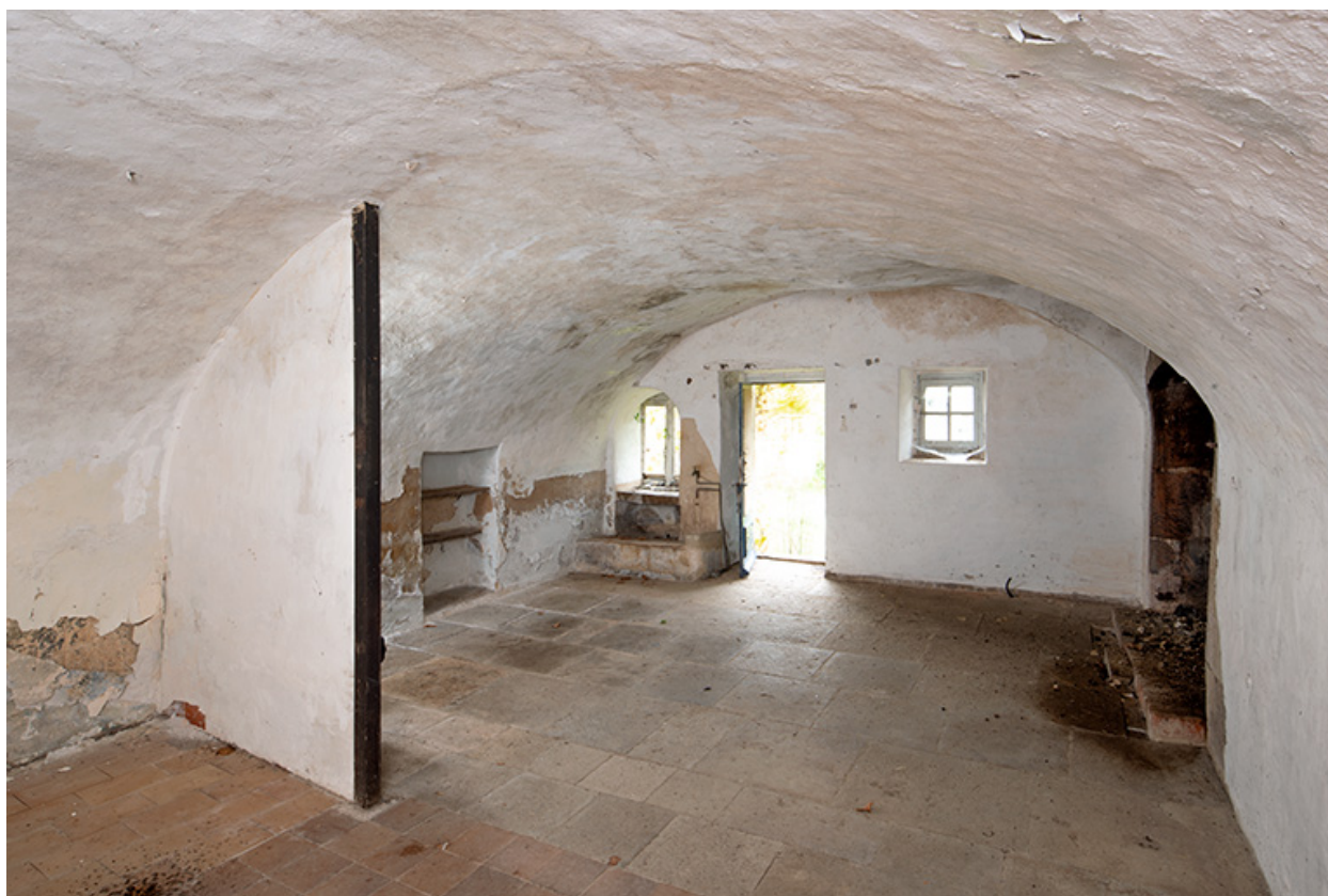
Le lois du corps de ferme, vue intérieure générale vers l'entrée.
