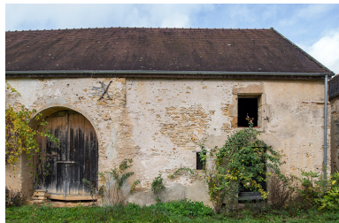
L'extrémité orientale de la ferme, depuis la cour. Phot. Nicolas Waltefaugle IVR26_20258900171NUC4A
