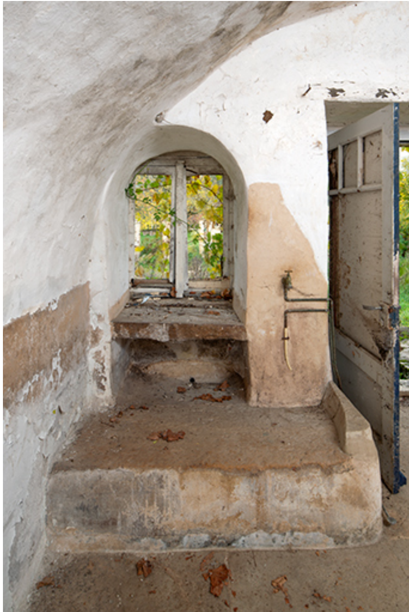
L'évier et la fenêtre dans le mur d'entrée du logis.
