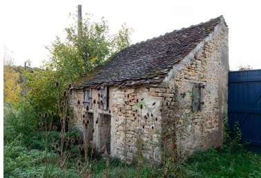
Le toit à porcs depuis l'entrée de la cour. Phot. Nicolas Waltefaugle IVR26_20258900169NUC4A
