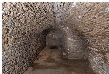
La cave située sous le cuvage, au nord. Phot. Nicolas Waltefaugle IVR26_20258900187NUC4A
