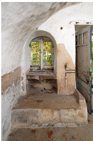
L'évier et la fenêtre dans le mur d'entrée du logis. Phot. Nicolas Waltefaugle IVR26_20258900200NUC4A
