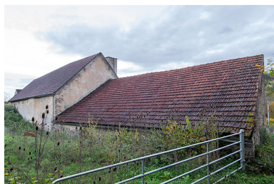
Le cuvette vu depuis le nord. Phot. Nicolas Waltefaugle IVR26_20258900192NUC4A
