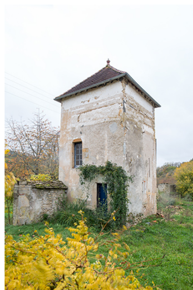
Le pigeonnier, vu depuis la demeure. Phot. Nicolas Waltefaugle IVR26_20258900204NUC4A
