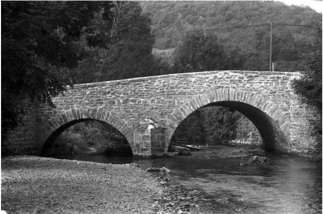
Pont situé rue de Nevy.
