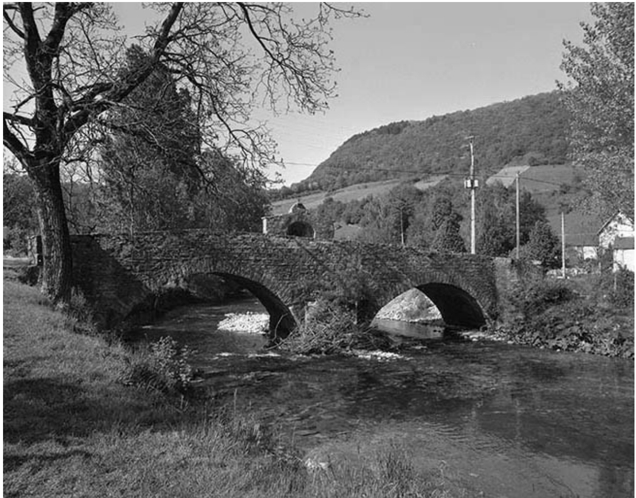
Pont oratoire situé chemin de Billin.
