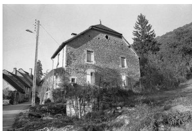
Maison cadastrée 1965 AD 105 : façade est. Phot. F. Pernin IVR43_19743900157Z
