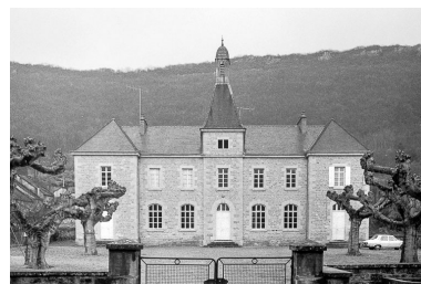
Mairie-école : façade antérieure.
