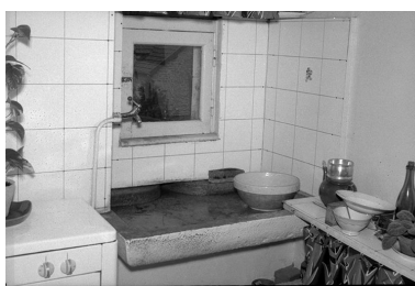
Maison cadastrée 1965 AD 105 : pierre d'évier. Phot. F. Pernin IVR43_19743900160Z
