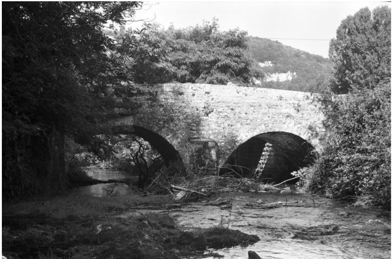
Pont situé route de la Vallée.
