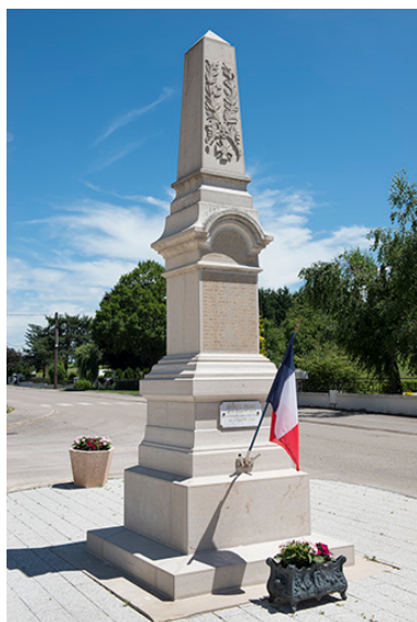
Vue d'ensemble, trois quart gauche. Phot. Jérôme Mongreville IVR43_20177000823NUC4A
