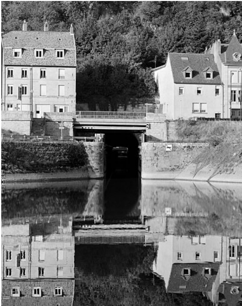
Porte de garde et extrémité amont.
