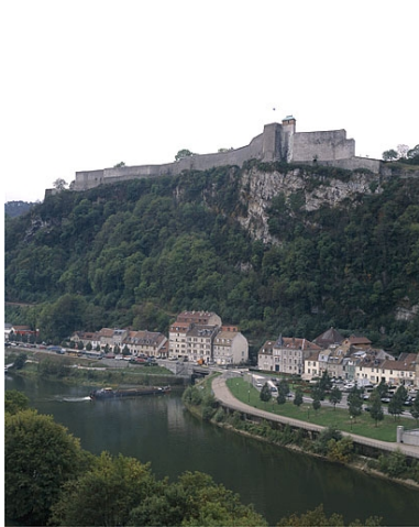
Vue d'ensemble plongeante sur l'extrémité amont. Phot. Jérôme Mongreville IVR43_20032500168XA
