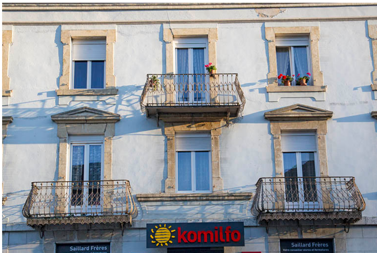
Immeuble au n° 11 : travées centrales.
