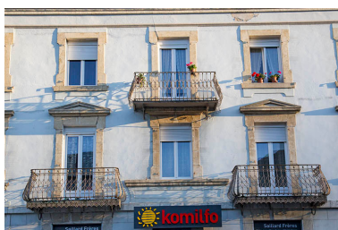
Immeuble au n° 11 : travées centrales. Phot. Yves Sancey IVR43_20132502373NUC2A
