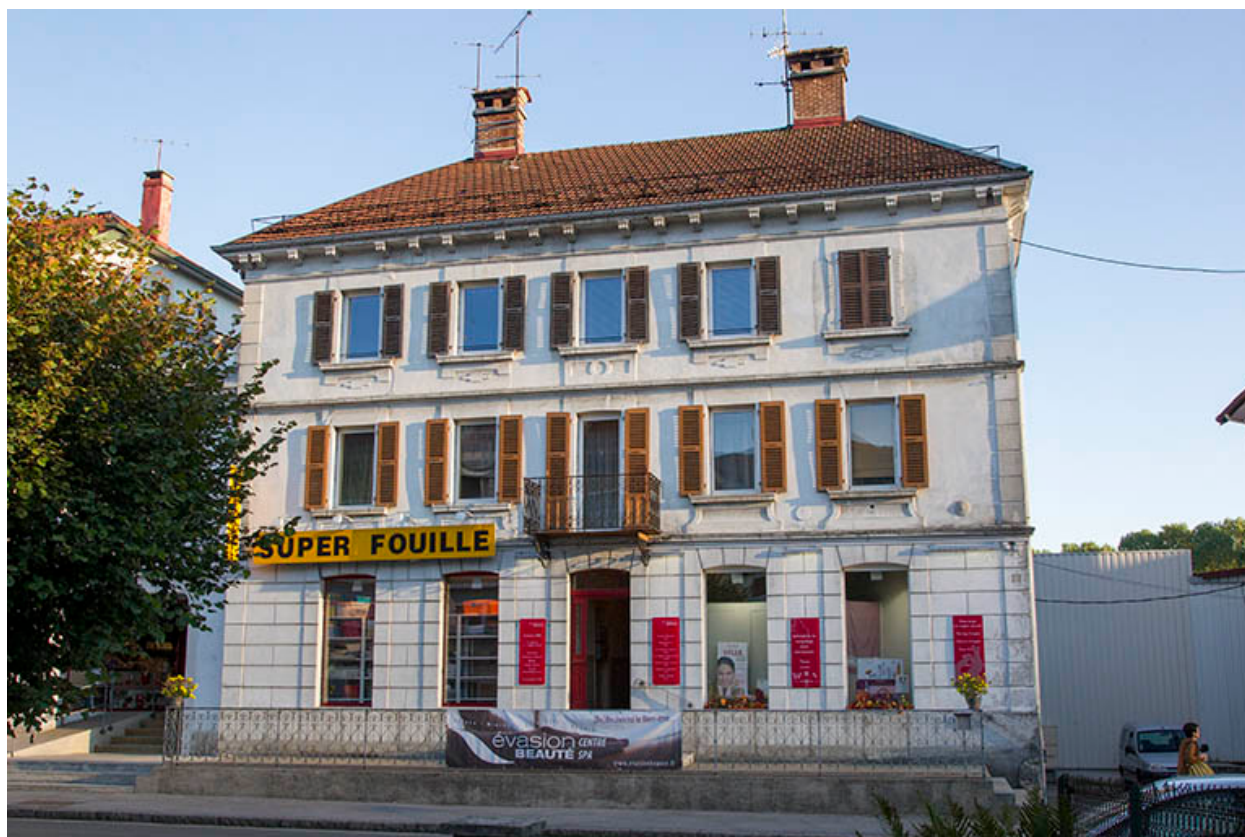
Immeuble au n° 13.
