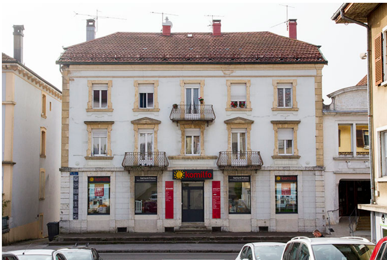
Immeuble au n° 11.
