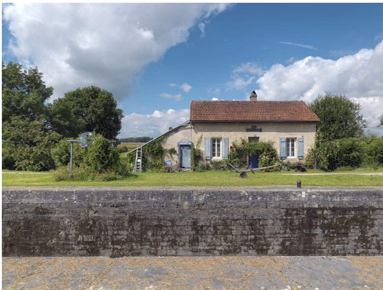
Maison éclusière de face.
