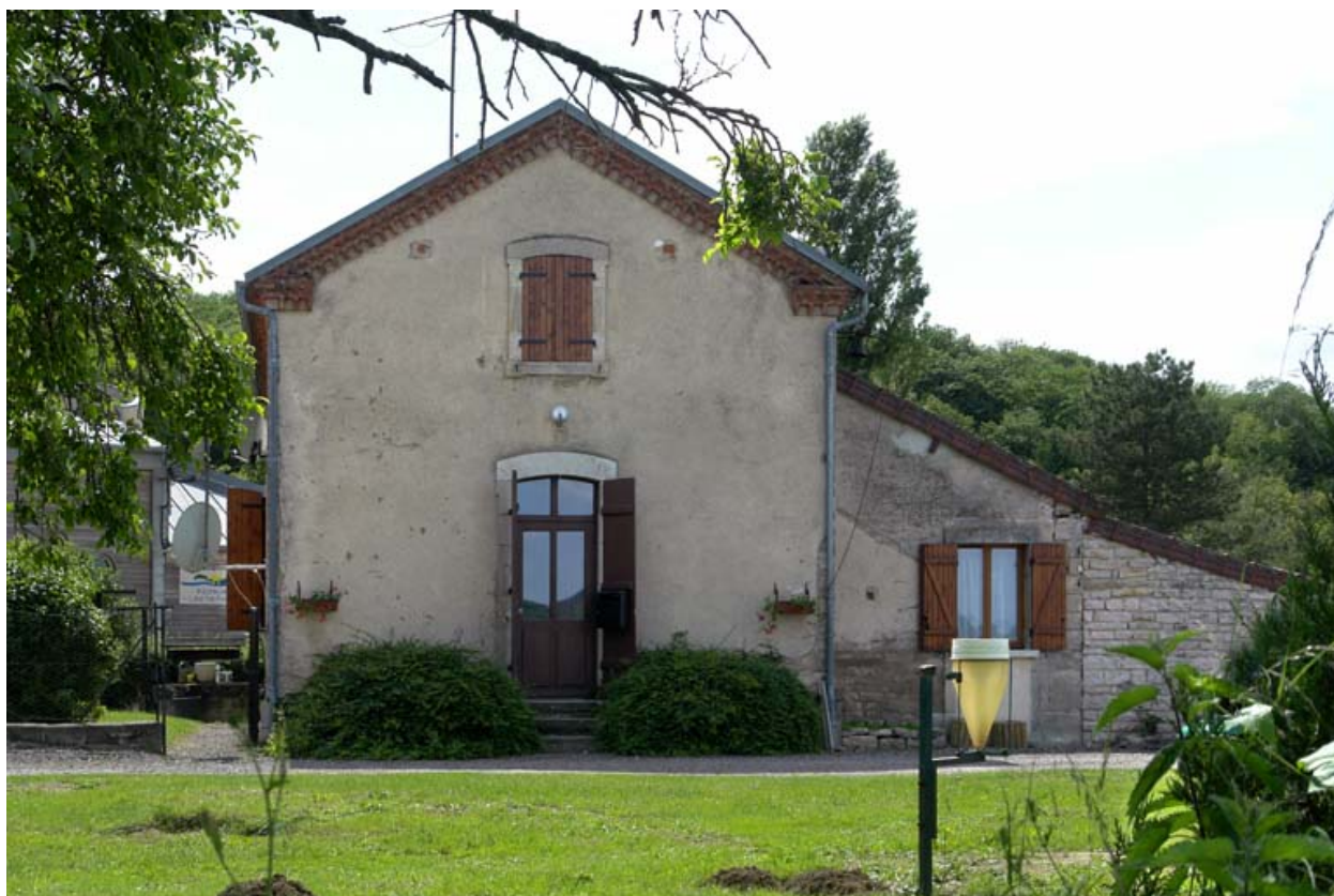
Maison de garde, élévation principale.
