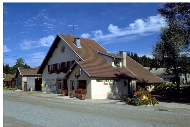
Vue d'ensemble. Phot. Yves Sancey IVR43_19973901453ZA
