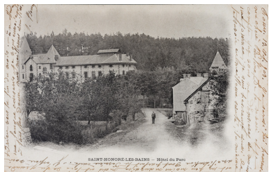
Vue d'ensemble depuis le nord-est. Phot. Pierre-Marie Barbe- Richaud, Autr. auteur inconnu IVR26_20195800433NUC4A
