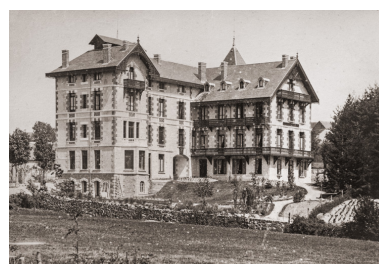
Façade sur le parc avant la destruction des balcons et galeries. Phot. Pierre-Marie Barbe-Richaud, Autr. auteur inconnu IVR26_20195800306NUC4A
