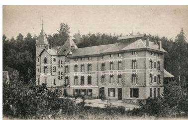
Façade sur la rue. Autr. auteur inconnu IVR26_20195800148NUC2A
