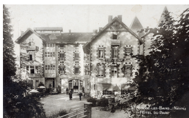
Façade sur le parc après la destruction des balcons et galeries. Phot. Pierre-Marie Barbe-Richaud, Autr. auteur inconnu IVR26_20195800432NUC2A
