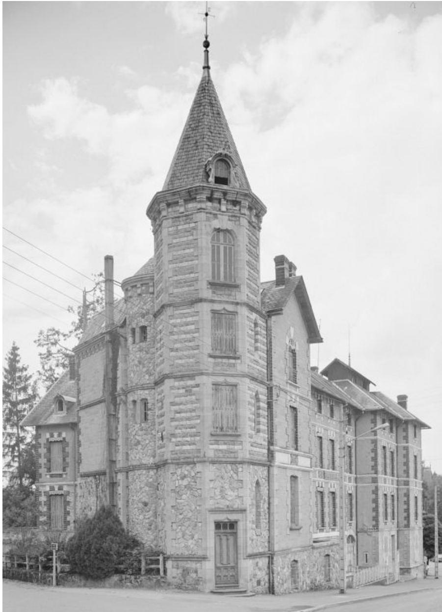
Tour de l'angle sud-ouest, vue d'ensemble en 1978.
