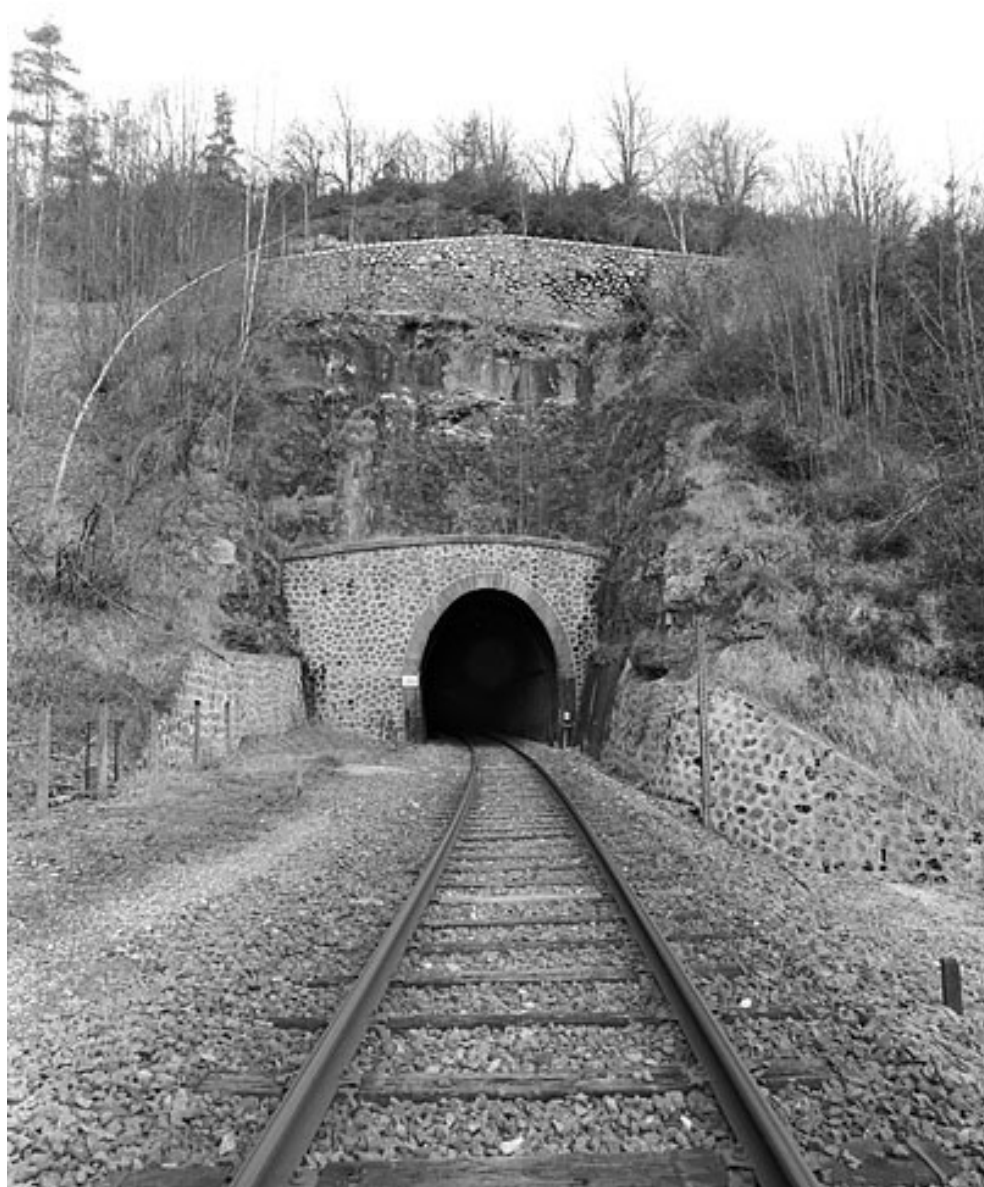
Tunnel : tête côté La Cluse (sud).
