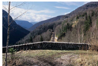
Tunnel : mur de protection de la tête côté La Cluse, depuis le chemin qui la surmonte, avec vue sur la vallée de la Bienne.
