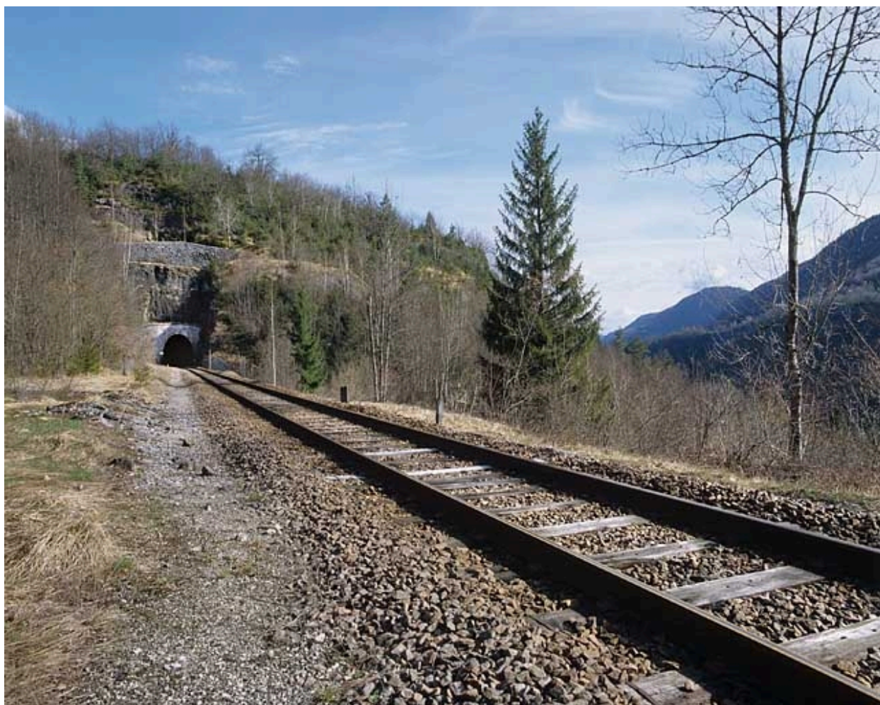
Vue d'ensemble, depuis le côté La Cluse (sud). A gauche, emplacement de l'ancienne station de Valfin.
