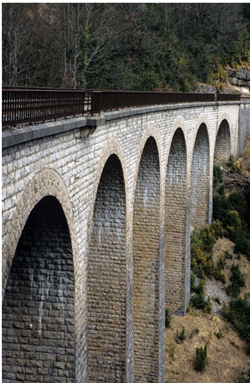
Viaduc : piles de l'élévation aval, vues en enfilade depuis le côté La Cluse.
