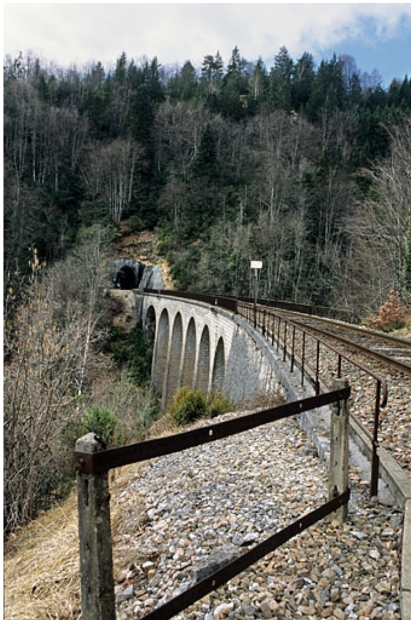
Vue d'ensemble, depuis le côté Andelot-en-Montagne (est).
