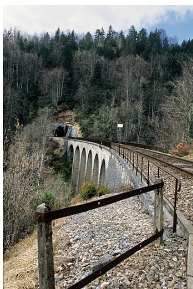
Vue d'ensemble, depuis le côté Andelot-en-Montagne (est). Phot. Yves Sancey IVR43_20053900694ZA
