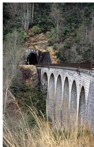
Viaduc : élévation aval, vue en enfilade depuis le côté Andelot-en-Montagne. Phot. Yves Sancey
