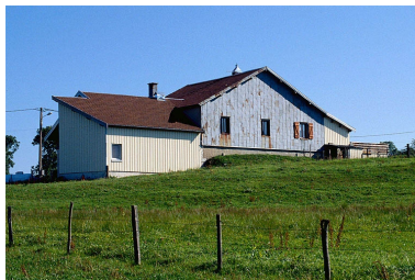
Façade postérieure. Phot. Yves Sancey IVR43_19973901090ZA
