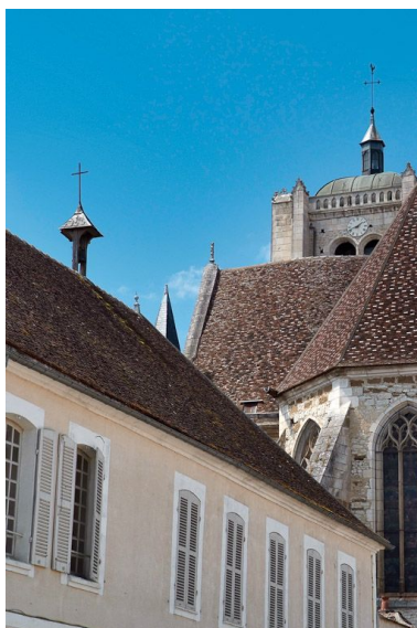
Immeuble nord, détail des fenêtres de l'étage. Phot. Pierre-Marie Barbe-Richaud IVR26_20088900075NUC2A
