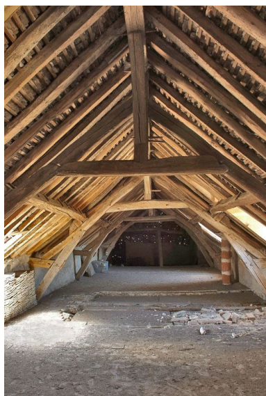
Comble et charpente du bâtiment sud. Phot. Pierre-Marie Barbe-Richaud IVR26_20088900089NUC2A
