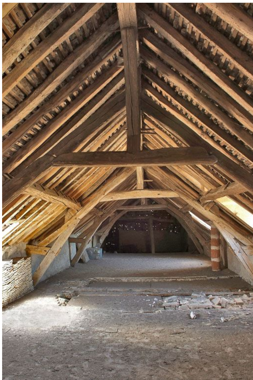
Comble et charpente du bâtiment sud.
