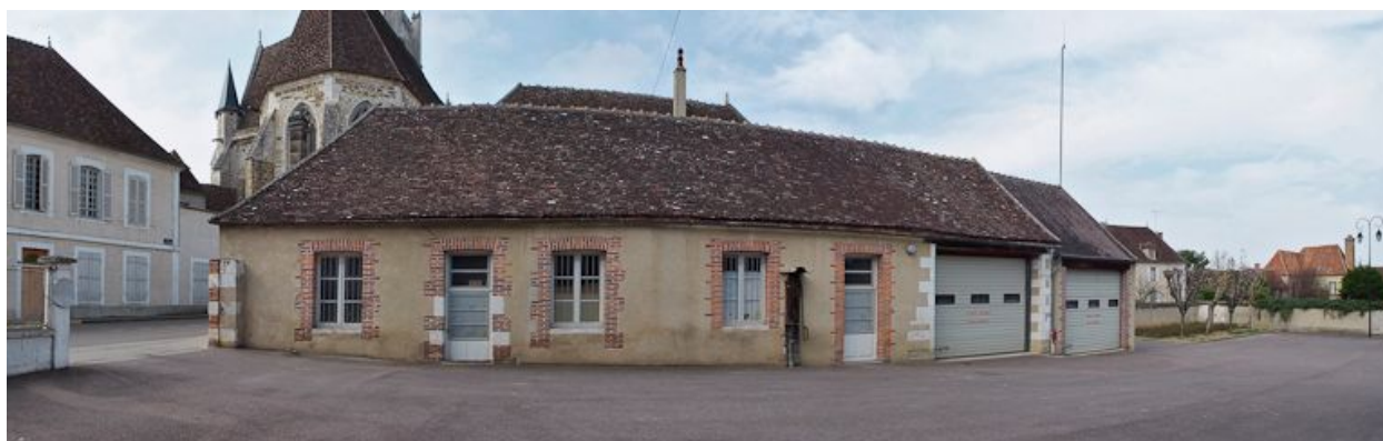
Anciennes dépendances servant actuellement aux pompiers.
