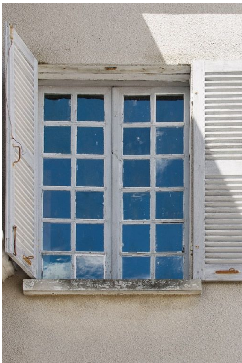
Bâtiment sud-ouest, détail d'une fenêtre.
