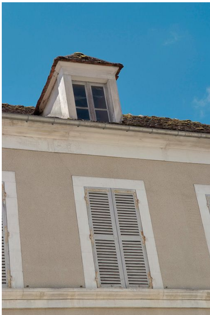
Bâtiment sud, lucarne et fenêtre.
