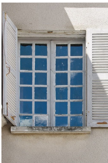
Bâtiment sud-ouest, détail d'une fenêtre. Phot. Pierre-Marie Barbe-Richaud IVR26_20088900079NUC2A
