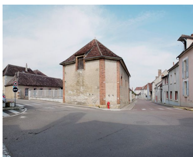
Anciennes dépendances, vue d'ensemble.
