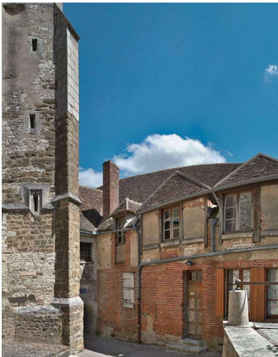
Façade postérieure du bâtiment sud-ouest.
