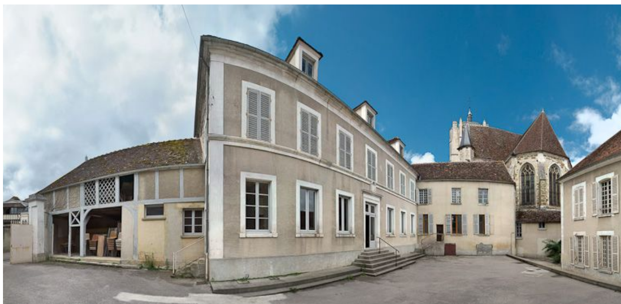
Vue d'ensemble des façades sur cour.
