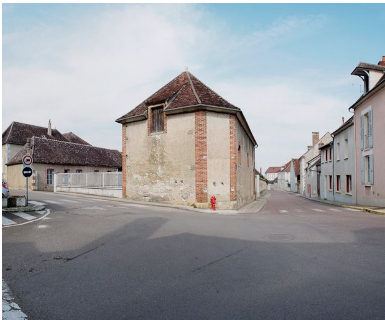
Anciennes dépendances, vue d'ensemble.
