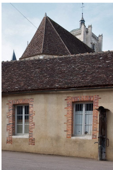
Anciennes dépendances, détail. Phot. Pierre-Marie Barbe-Richaud IVR26_20098900031NUC2A
