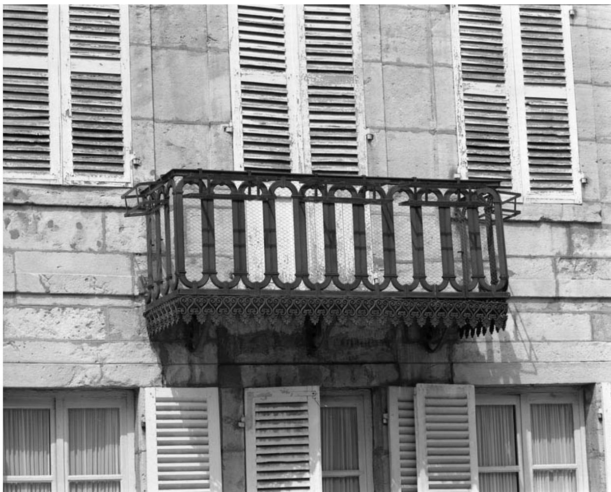
Façade antérieure : détail du balcon en ferronnerie.
