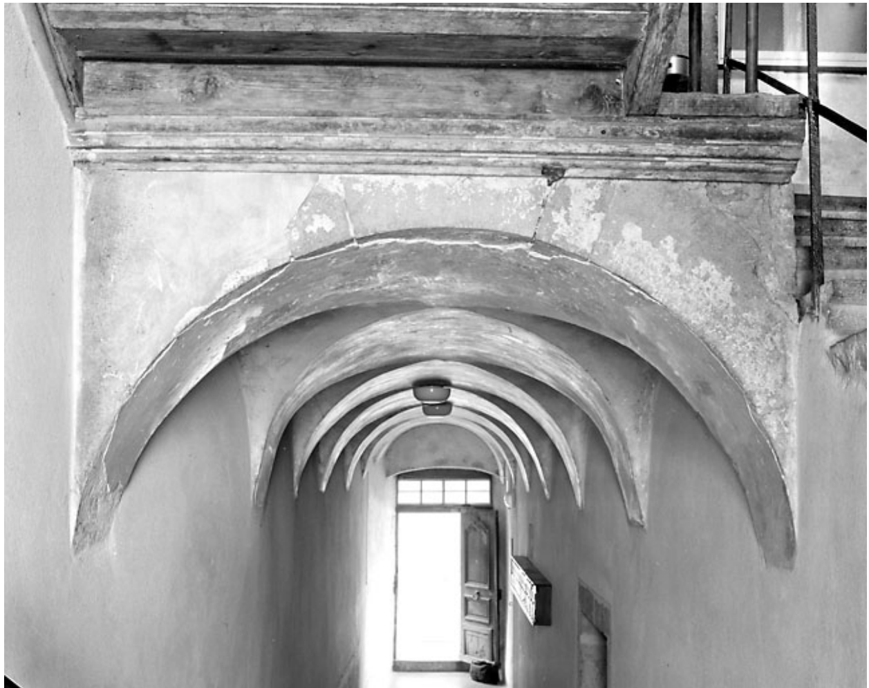
Voûte d'arêtes du couloir.
