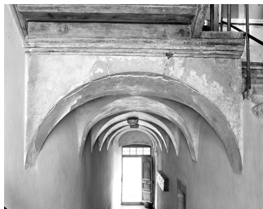
Voûte d'arêtes du couloir. Phot. Yves Sancey IVR43_20033900700X
