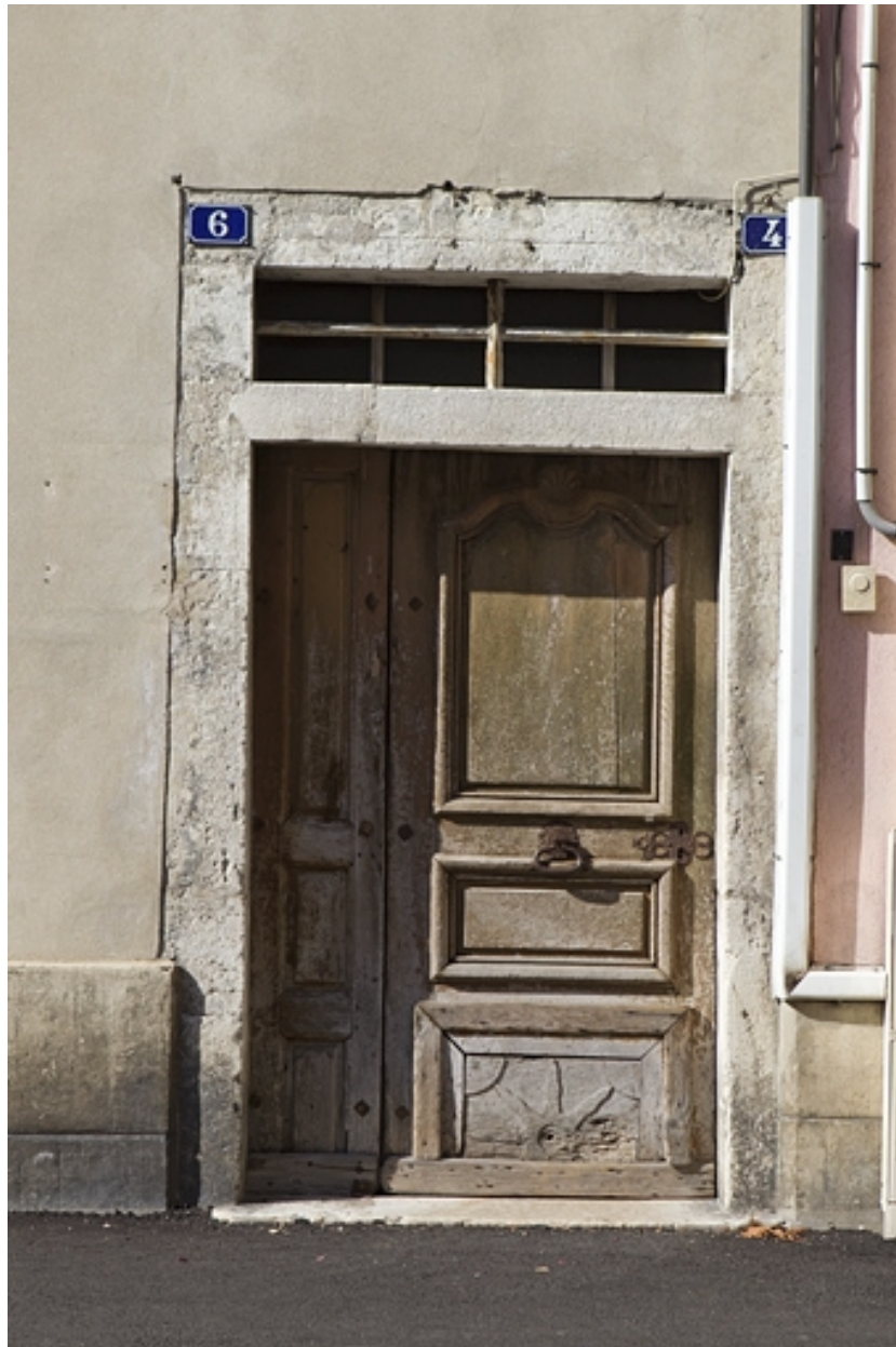
Porte principale sur la rue Merlin.
