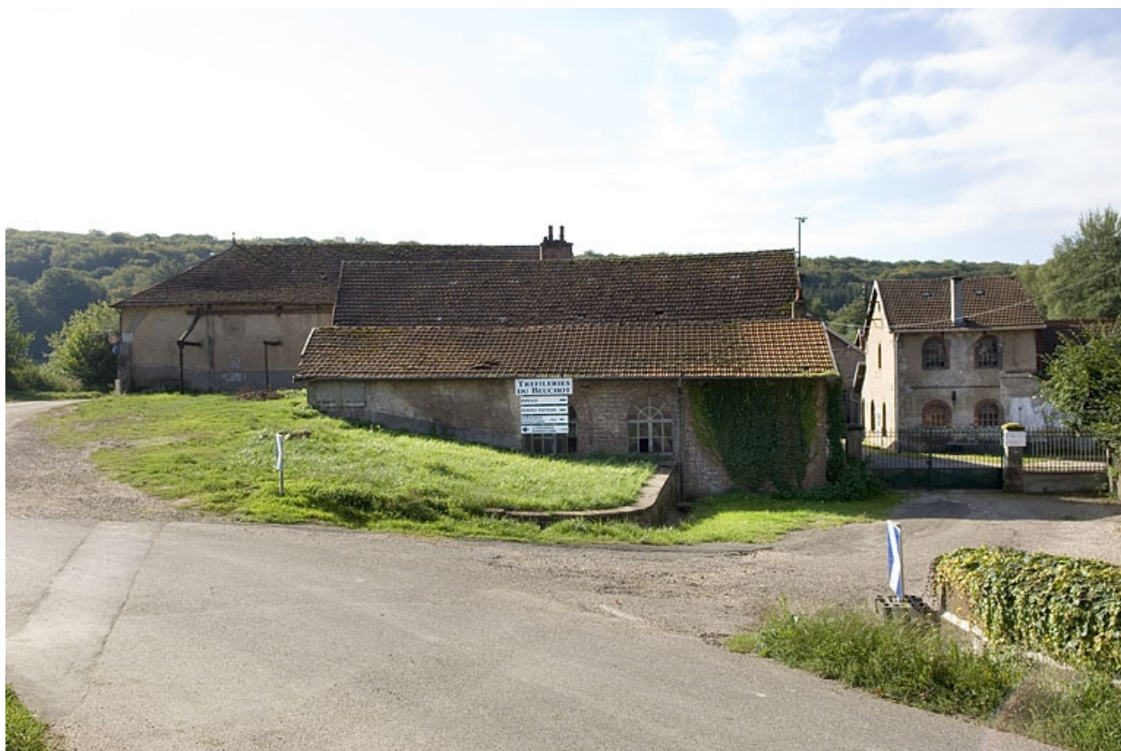
Les bâtiments à l'entrée de l'usine.
