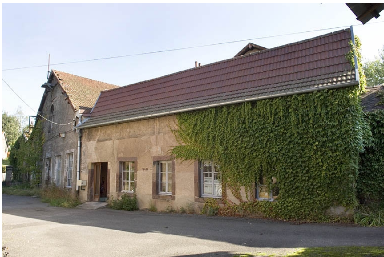
Atelier de réparation vu de trois quarts.
