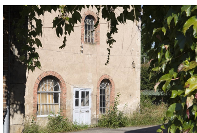
Façade est d'un atelier. Phot. Jérôme Mongreville IVR43_20097000863NUC2A
