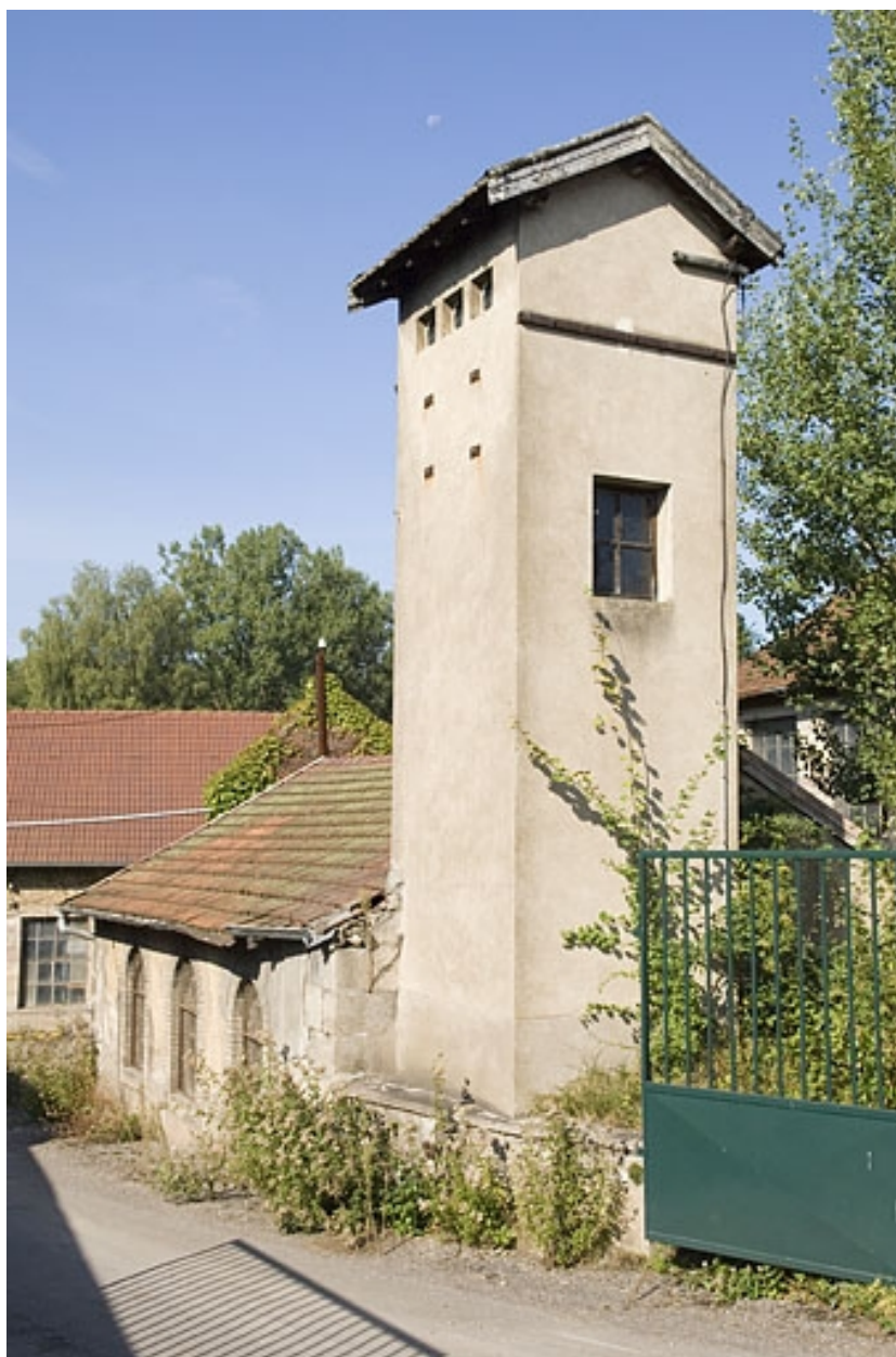
Le transformateur électrique depuis l'entrée.
