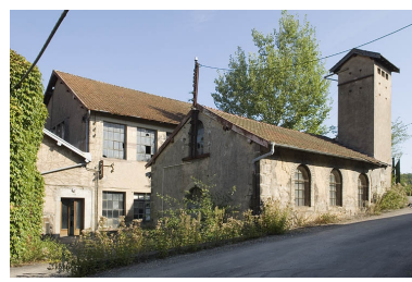
Local technique et transformateur électrique à l'entrée. Phot. Jérôme Mongreville IVR43_20097000859NUC2A
