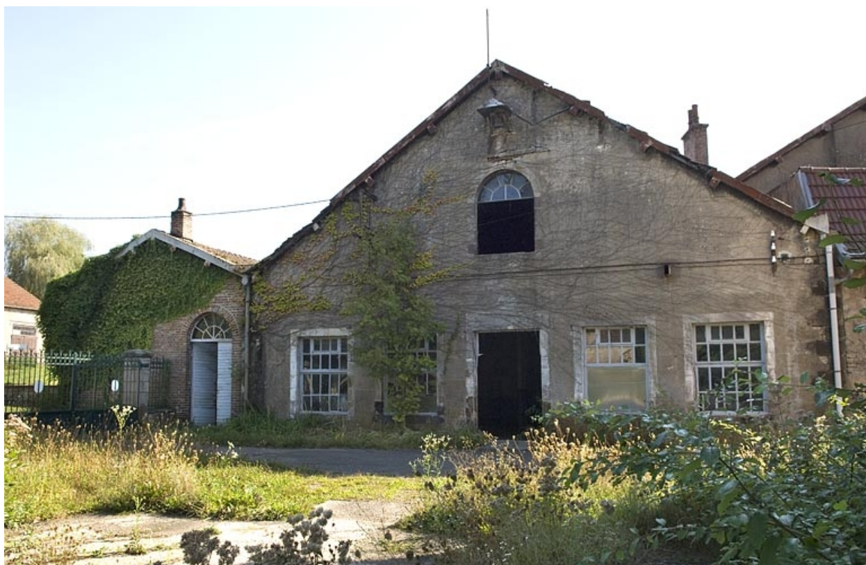
Pignon de l'atelier de réparation.
