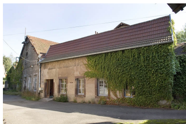
Atelier de réparation vu de trois quarts. Phot. Jérôme Mongreville IVR43_20097000866NUC2A
