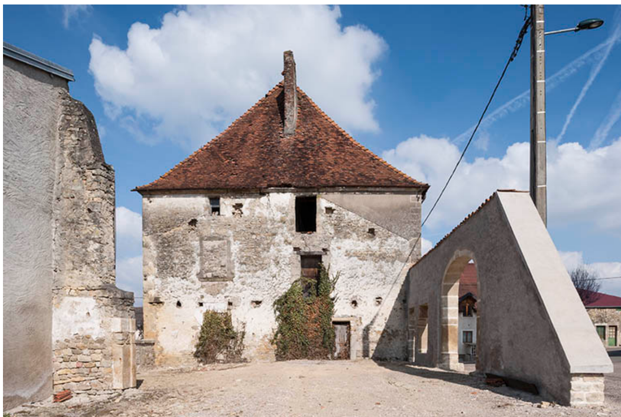
Mur pignon sud.
