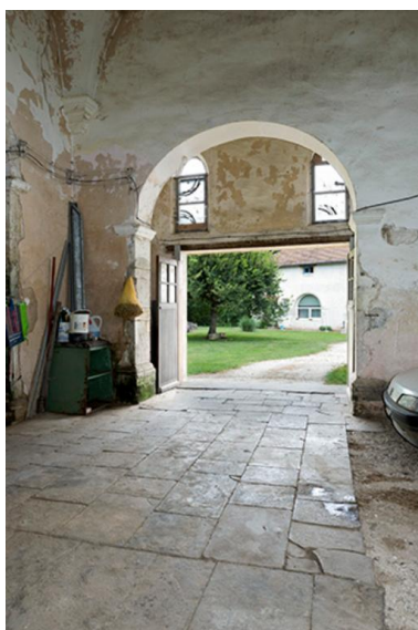
Vue de l'entrée donnant sur la cour Phot. Sonia Dourlot IVR43_20167001108NUC4A
