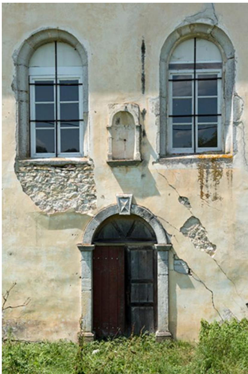
Façade principale de la chapelle
