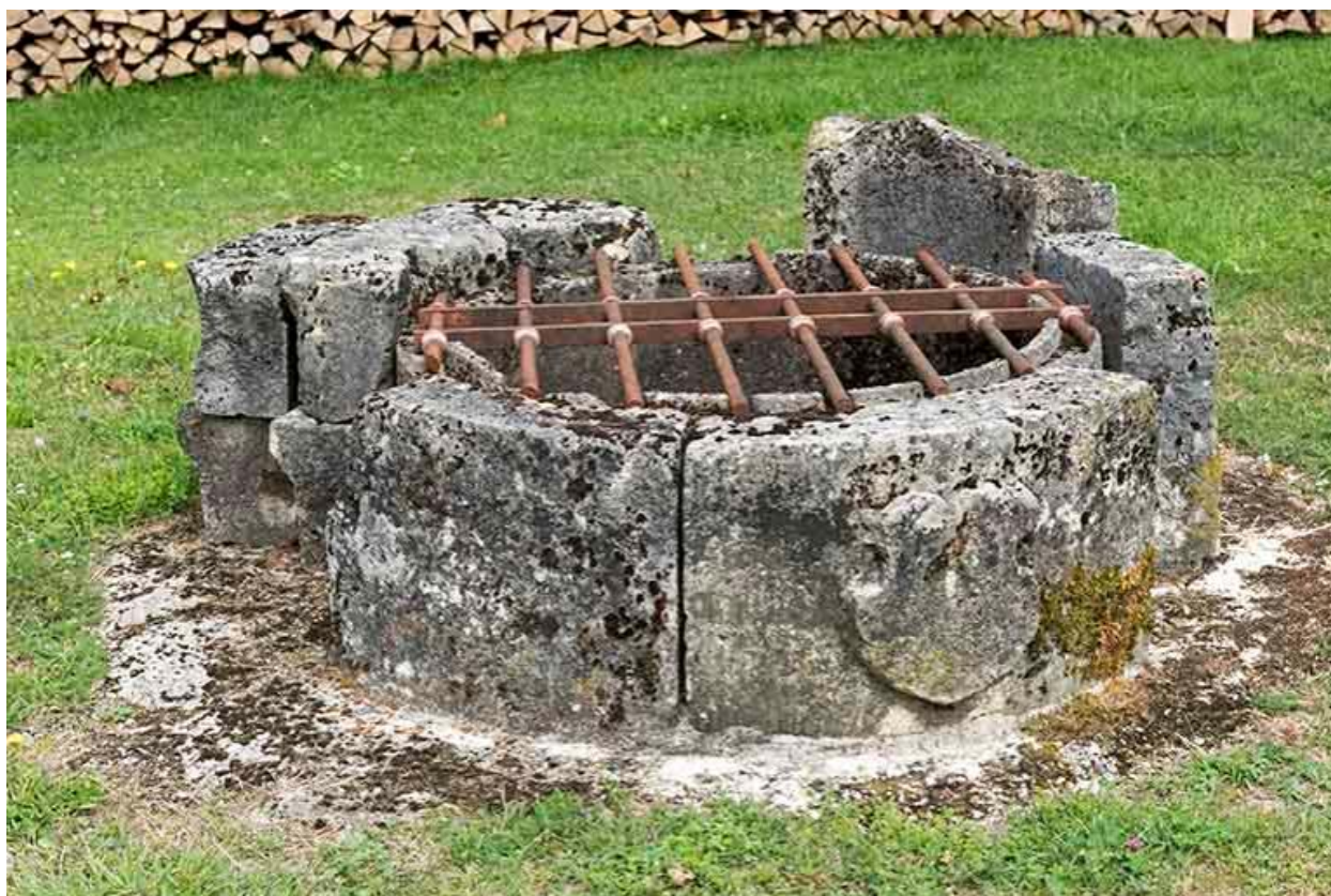
Puits situé dans la cour
