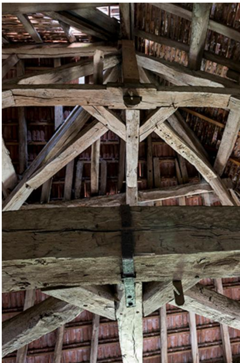
Poutrage du grenier de la chapelle
