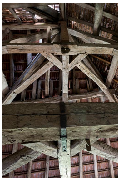
Poutrage du grenier de la chapelle Phot. Sonia Dourlot IVR43_20167001106NUC4A
