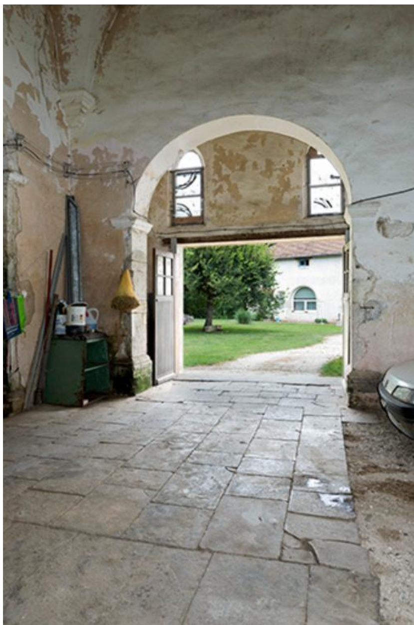
Vue de l'entrée donnant sur la cour
