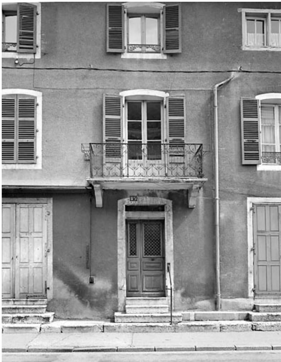
Façade antérieure : travée centrale.
