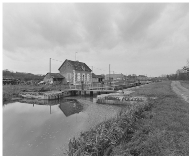
L'écluse n°33, dite de Mont : vue d'ensemble prise de l'amont. Phot. Jean-Luc Duthu IVR26_19925800275X
