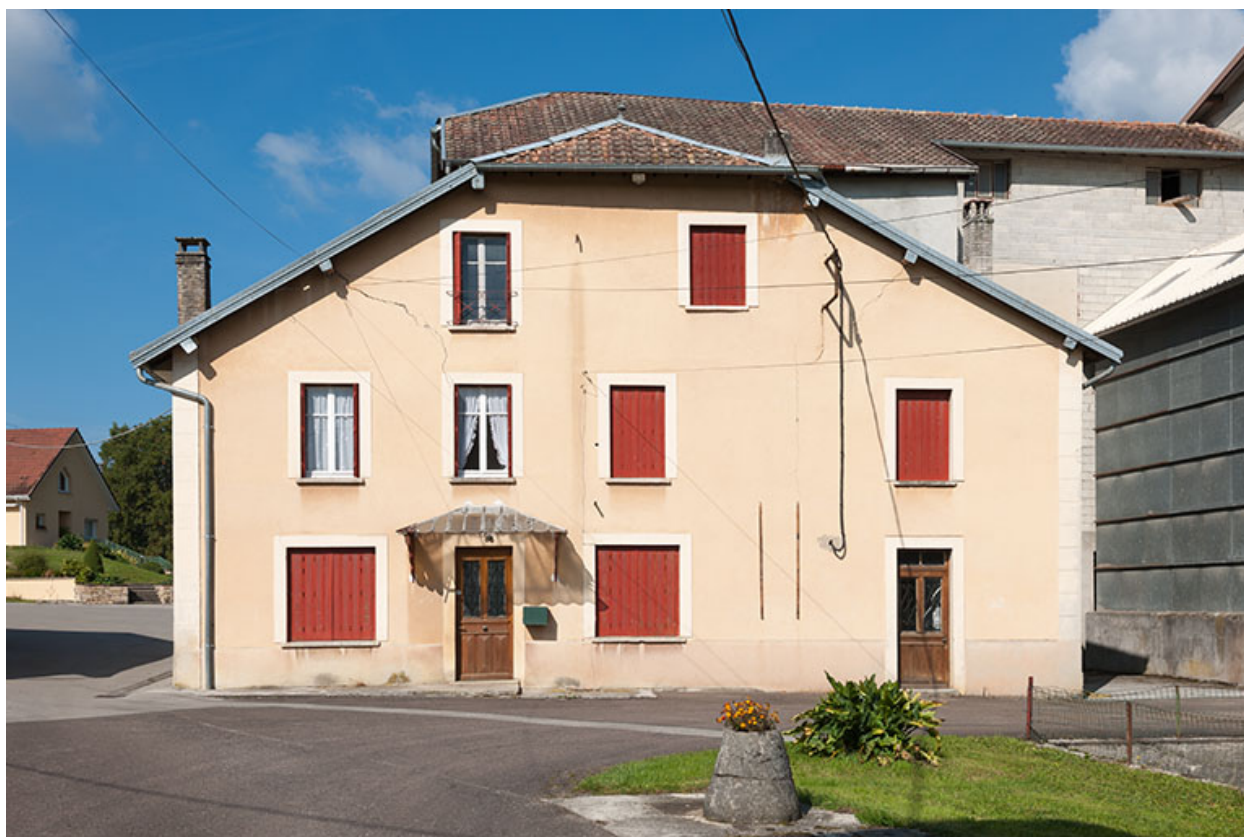
Façade sud du logement.
