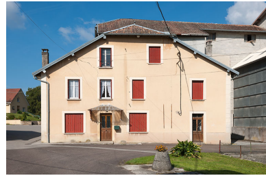
Façade sud du logement. Phot. Jérôme Mongreville IVR43_20142501634NUC4A
