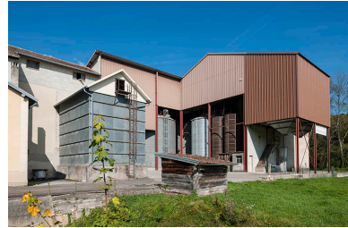
Silos à blé et pont bascule. Phot. Jérôme Mongreville IVR43_20142501635NUC4A
