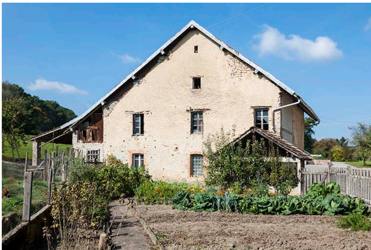
Vestige de la ferme, depuis le sud.
