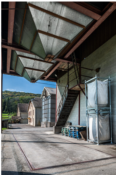
Vue depuis le pont bascule. Phot. Jérôme Mongreville IVR43_20142501637NUC4A
