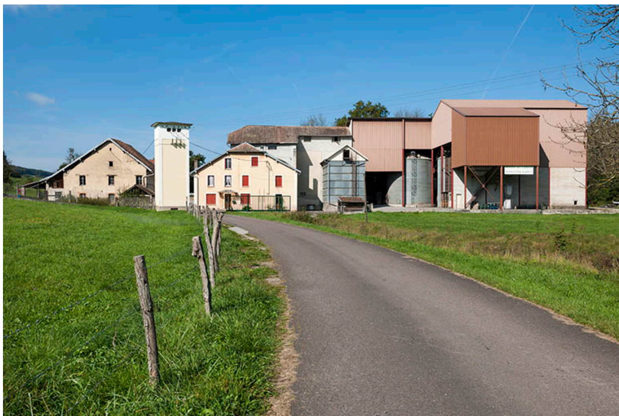
Vue depuis la route d'accès.
