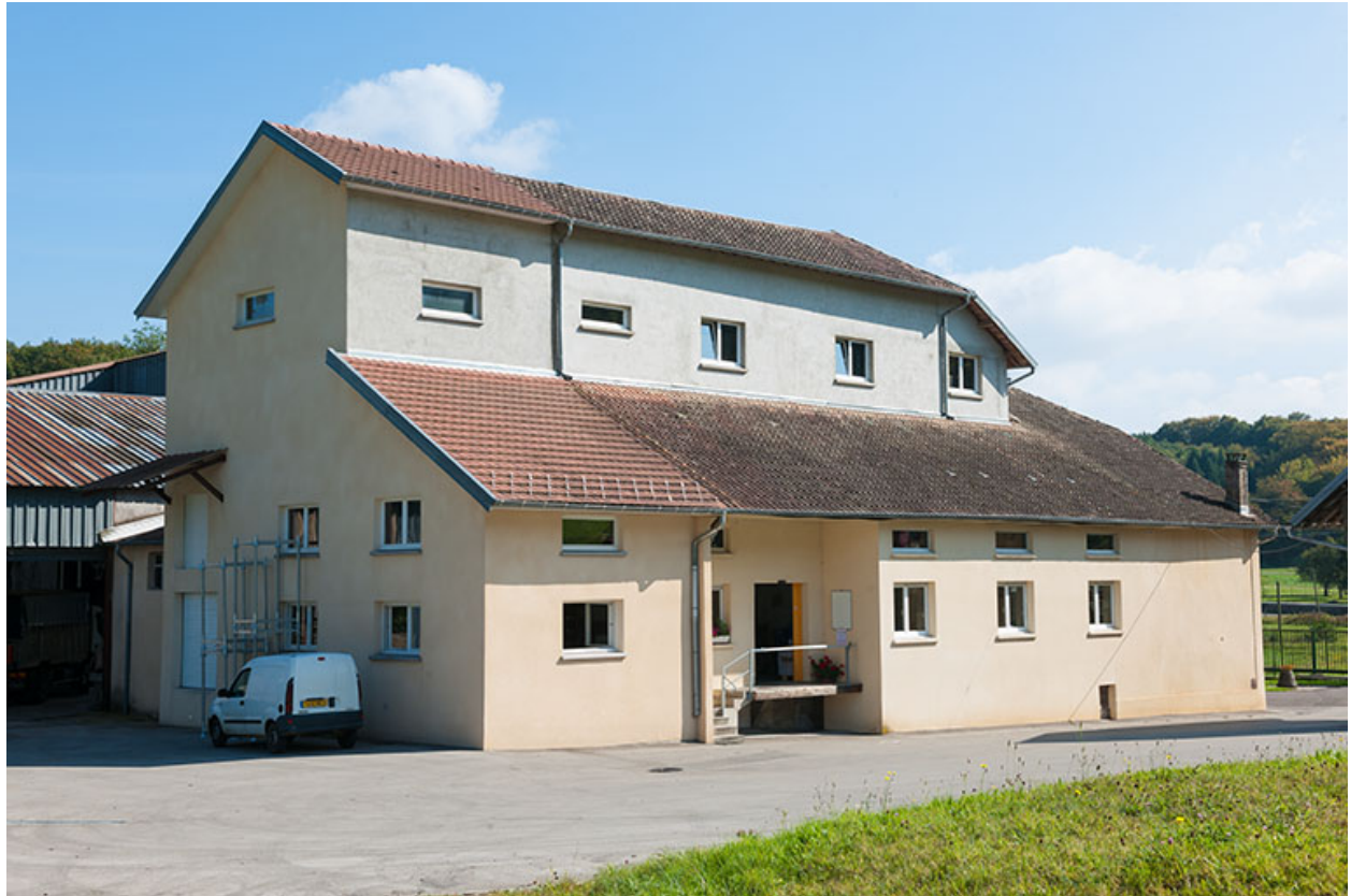
L'atelier du moulin, depuis le nord-est.
