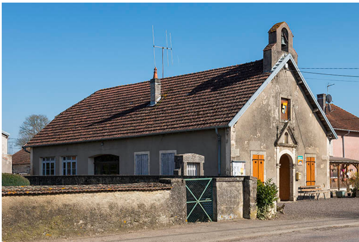
Vue latérale de l'édifice.
