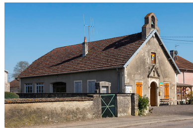
Vue latérale de l'édifice.
