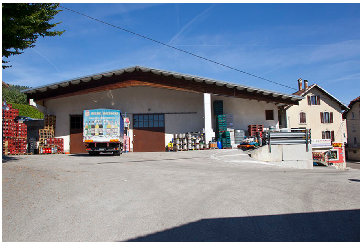
Grand entrepôt, depuis le sud.
