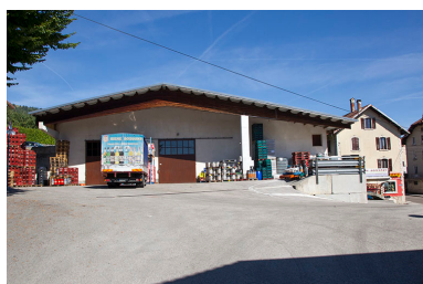
Grand entrepôt, depuis le sud. Phot. Yves Sancey IVR43_20132502311NUC2A
