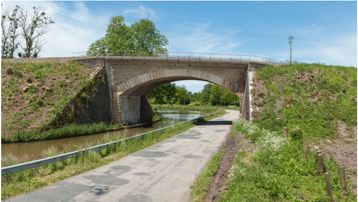
Le pont, vu d'amont.
