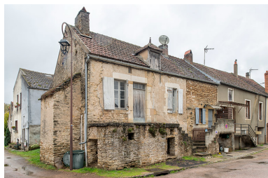
La maison, depuis la rue de l'abbé Pissier. Phot. Nicolas Waltefaugle IVR26_20258900317NUC4A
