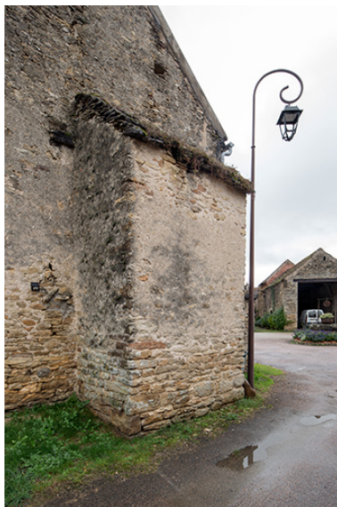
Le four, depuis la rue des Pierres. Phot. Nicolas Waltefaugle IVR26_20258900319NUC4A
