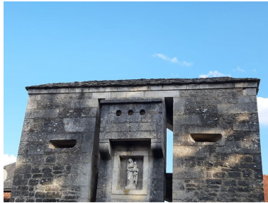
Vue de la partie supérieure de la porte de ville, couverte en laves.
