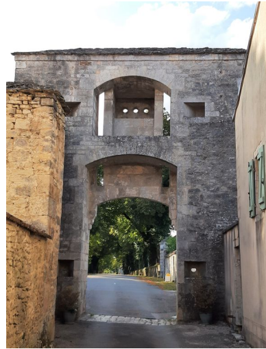
Vue intérieure de la porte de ville, depuis le sud-est.
