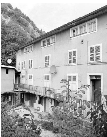
Façade principale : extension de 1861. Phot. Yves Sancey IVR43_20033900172X
