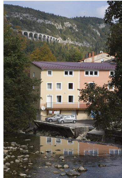
Vue d'ensemble depuis le sud, après restauration. Phot. Yves Sancey IVR43_20093900092NUC2A
