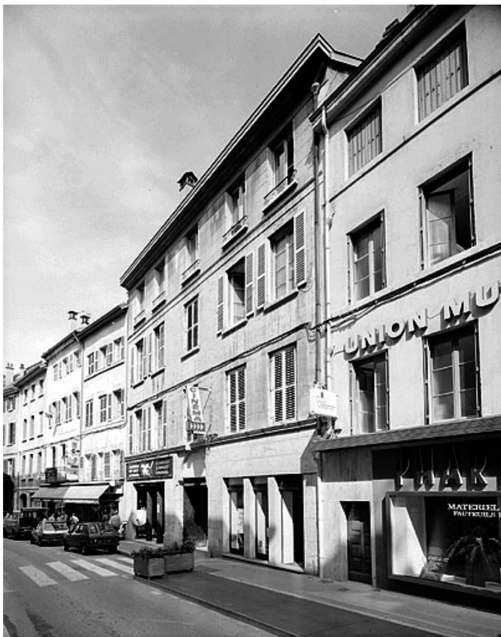
Bâtiment rue de la Poyat : façade antérieure.
