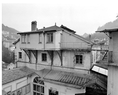
Façade du théâtre et cabine de projectionniste. Phot. Jérôme Mongreville IVR43_19933900021X
