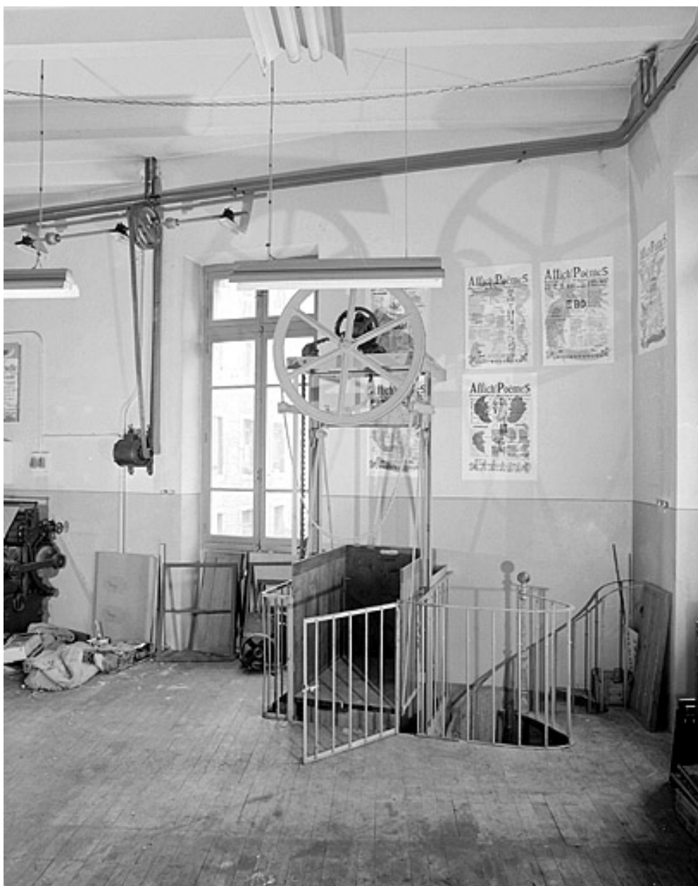
Ancien monte-charge de l'imprimerie.
