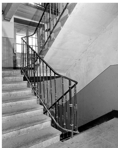
Escalier. Phot. Jérôme Mongreville IVR43_19923900570X
