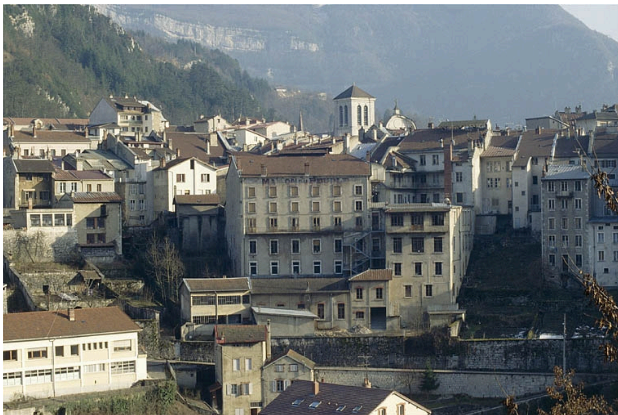
Façades sur la Bienne.
