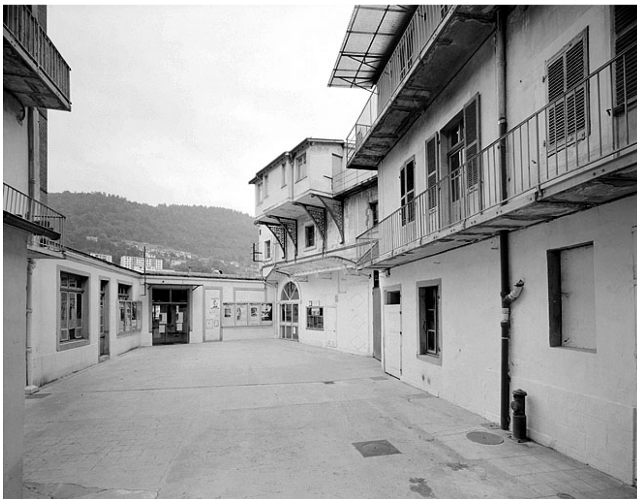
Cour intérieure, depuis l'entrée.
