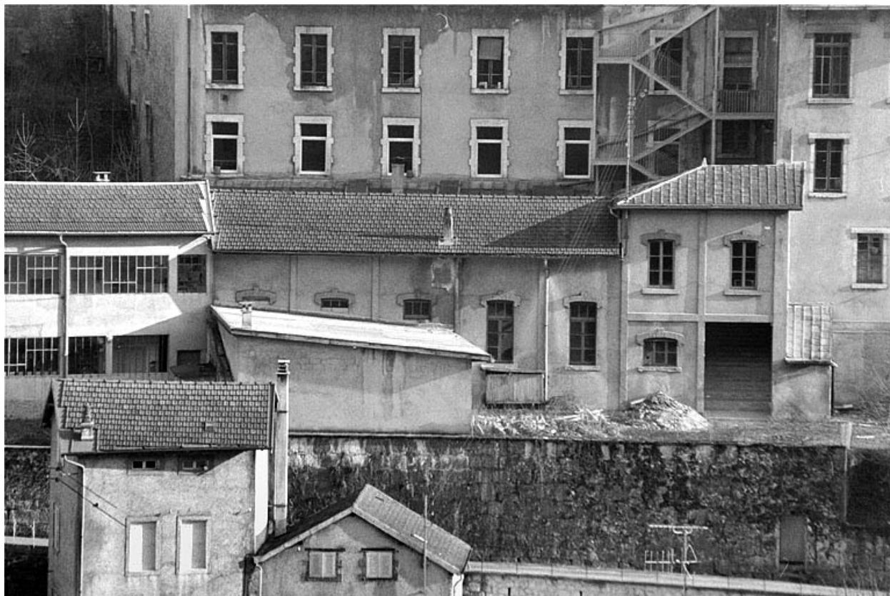
Gymnase : façade sur la Bienne.
