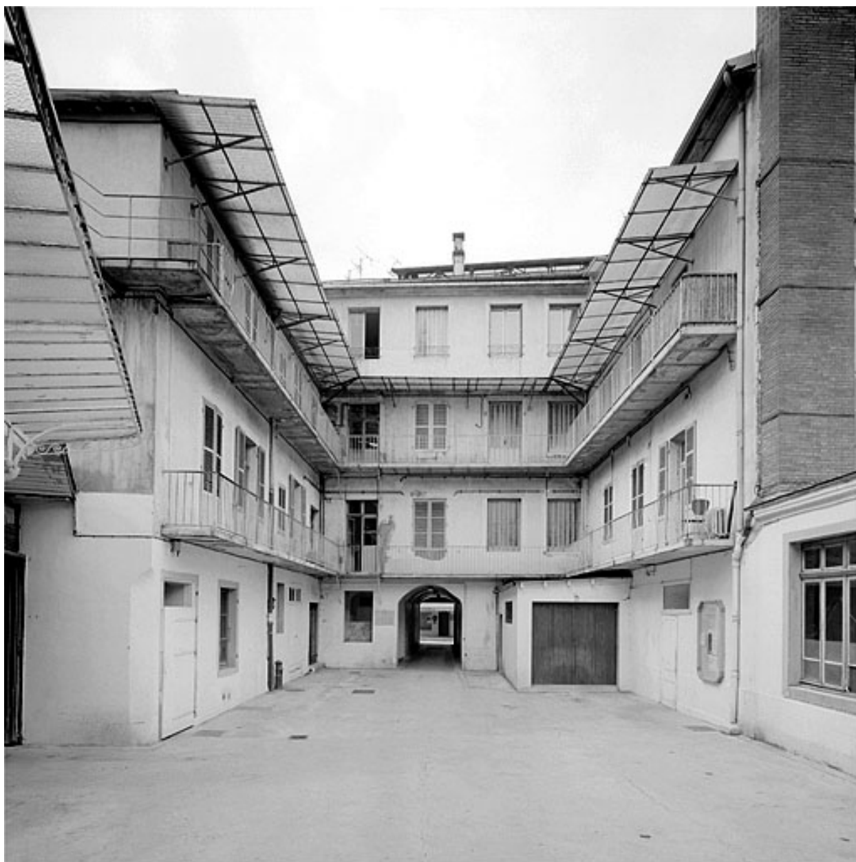
Bâtiment rue de la Poyat : façade postérieure.
