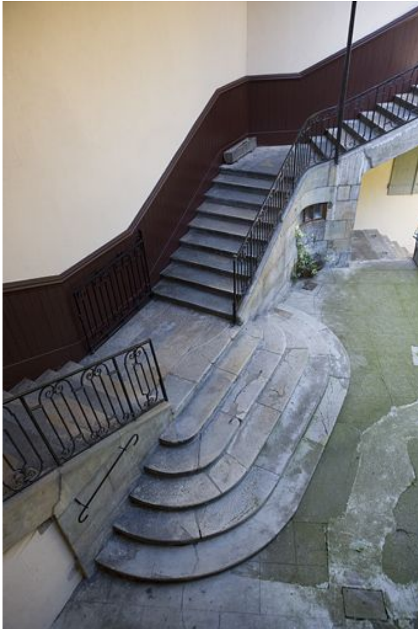
Vue de l'escalier à cage ouverte, en plongée.
