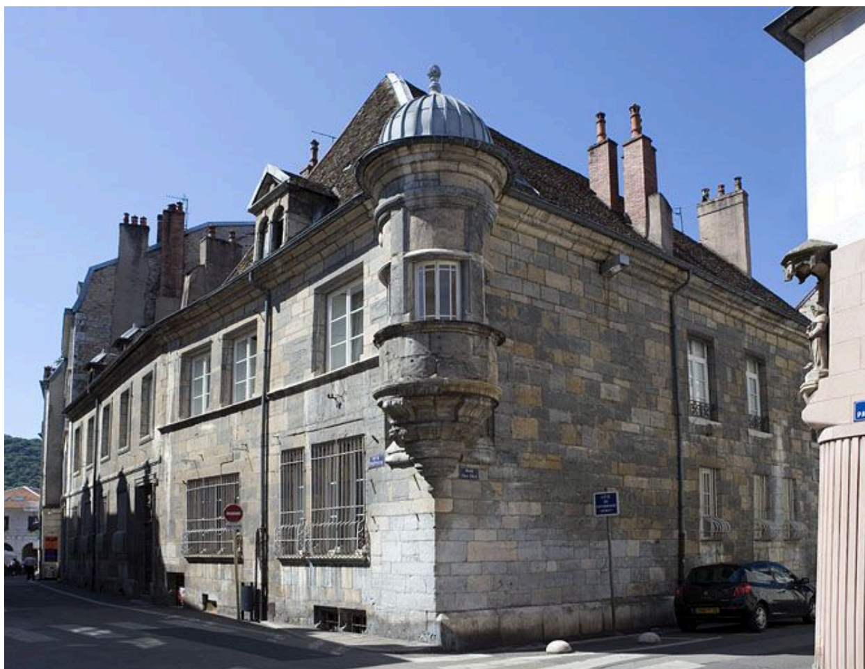
Vue d'ensemble du logis principal, de trois quarts droit.
