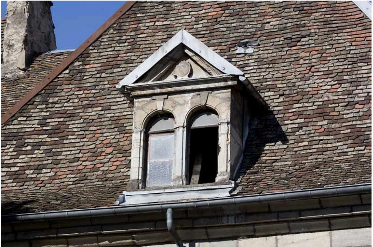
Détail de la lucarne.
