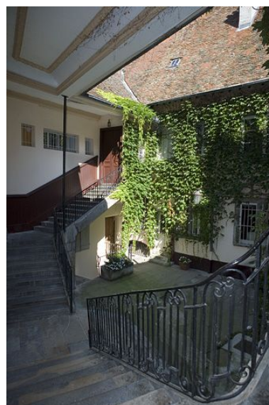
Vue de la cour depuis l'escalier à cage ouverte. Phot. Yves Sancey IVR43_20082500382NUC2A
