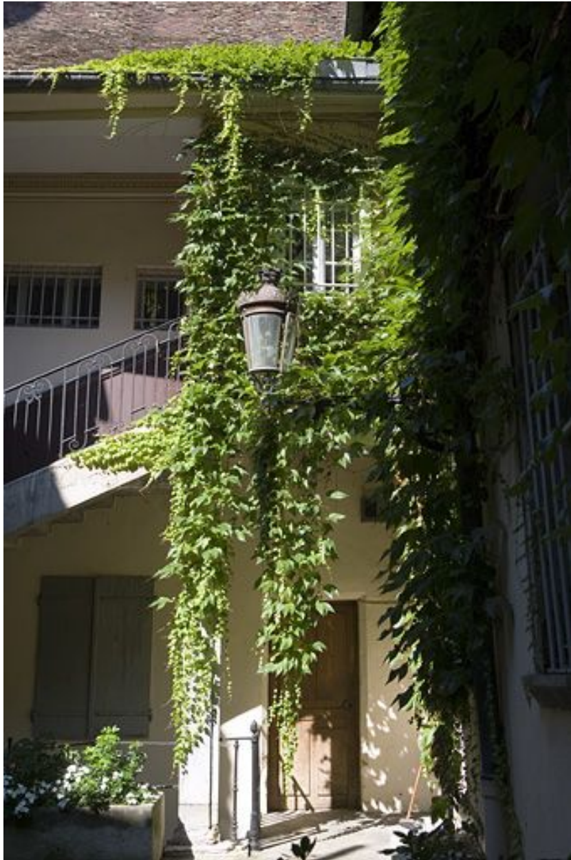
Vue de la partie droite de l'escalier à cage ouverte.
