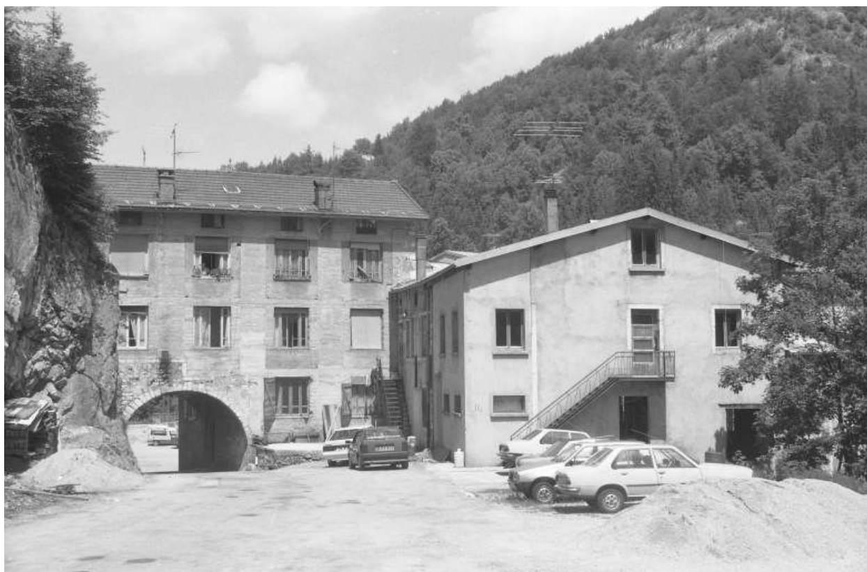
Vue d'ensemble depuis le sud-est (amont).
