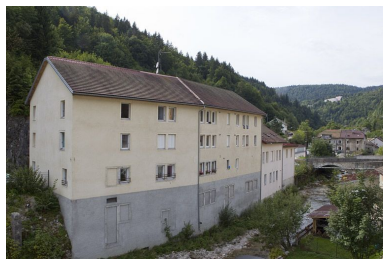
Façade sur la Bienne depuis l'est (amont). Phot. Yves Sancey IVR43_20103900619NUC2A
