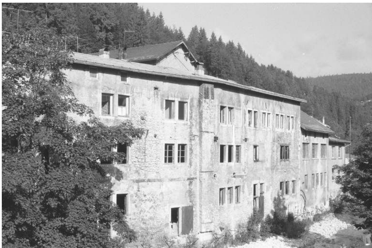
Façade sur la Bienne depuis l'est (amont).
