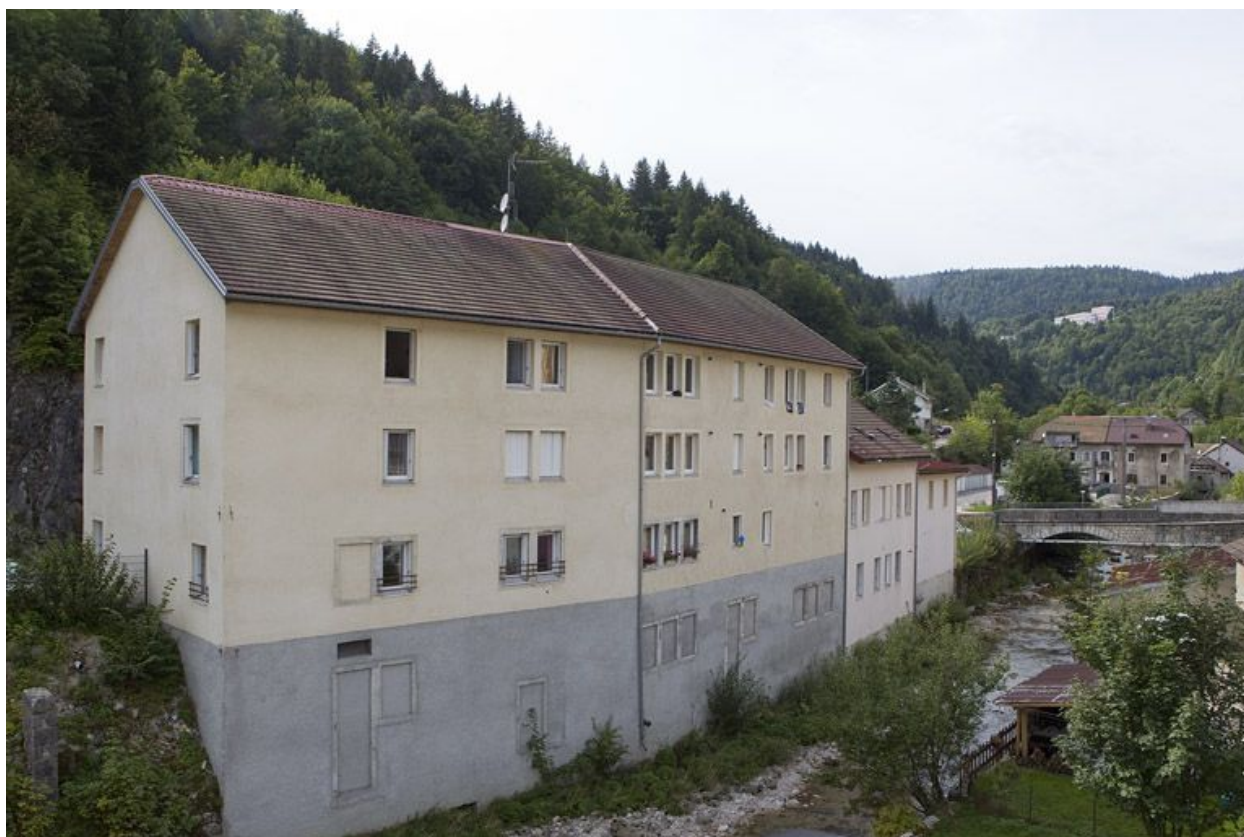
Façade sur la Bienne depuis l'est (amont).
