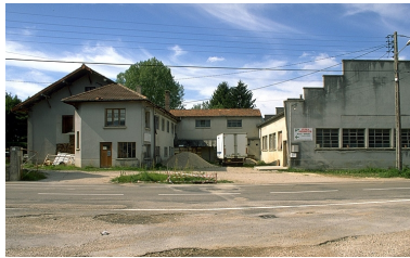
Façades antérieures. Phot. Yves Sancey IVR43_19973901288ZA
