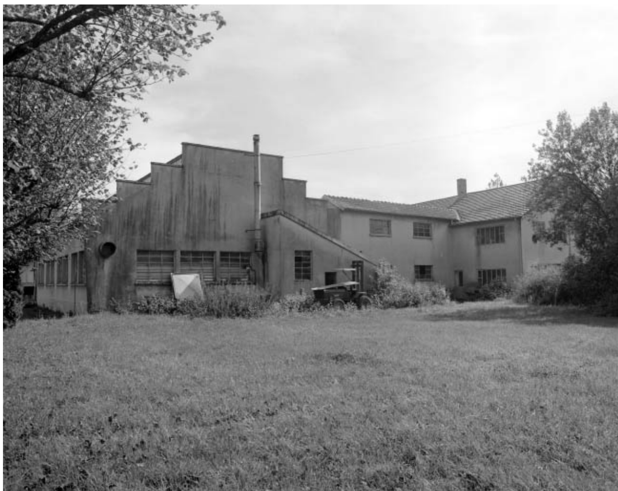
Façades postérieures des ateliers de fabrication.
