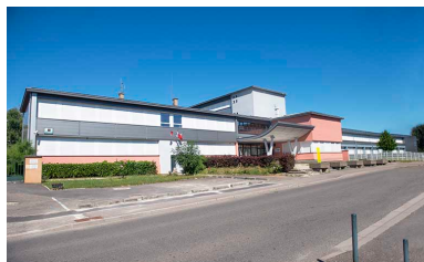
Façade antérieure sur rue. Phot. Mary Ruffinoni IVR43_20137000653NUC4A
