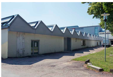
Façade est des ateliers sous sheds. Phot. Mary Ruffinoni IVR43_20137000644NUC4A
