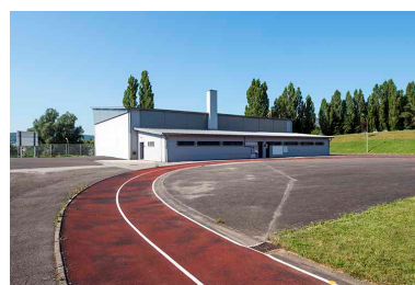
Angle nord-est du gymnase. Phot. Mary Ruffinoni IVR43_20137000629NUC4A
