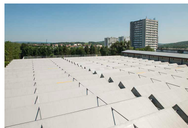
Couverture en sheds des ateliers. Phot. Mary Ruffinoni IVR43_20137000649NUC4A
