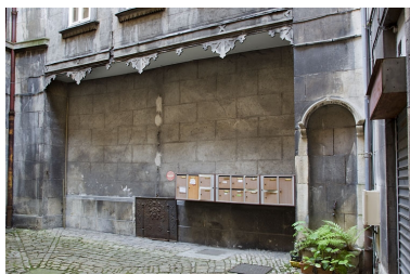
Première cour : vue d'ensemble du puits. Phot. Yves Sancey IVR43_20112500751NUC2A
