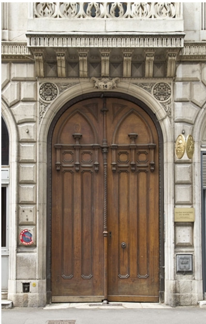
Vue des vantaux du portail d'entrée.
