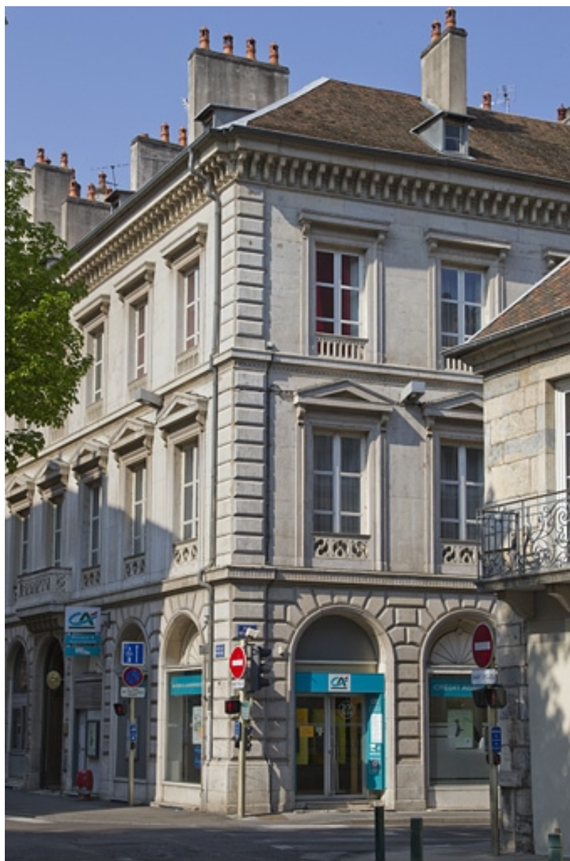
Logis principal : vue de l'angle sur rue.
