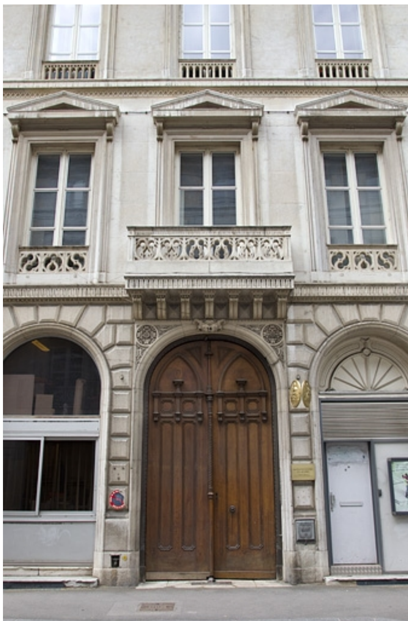
Vue d'ensemble du portail d'entrée.
