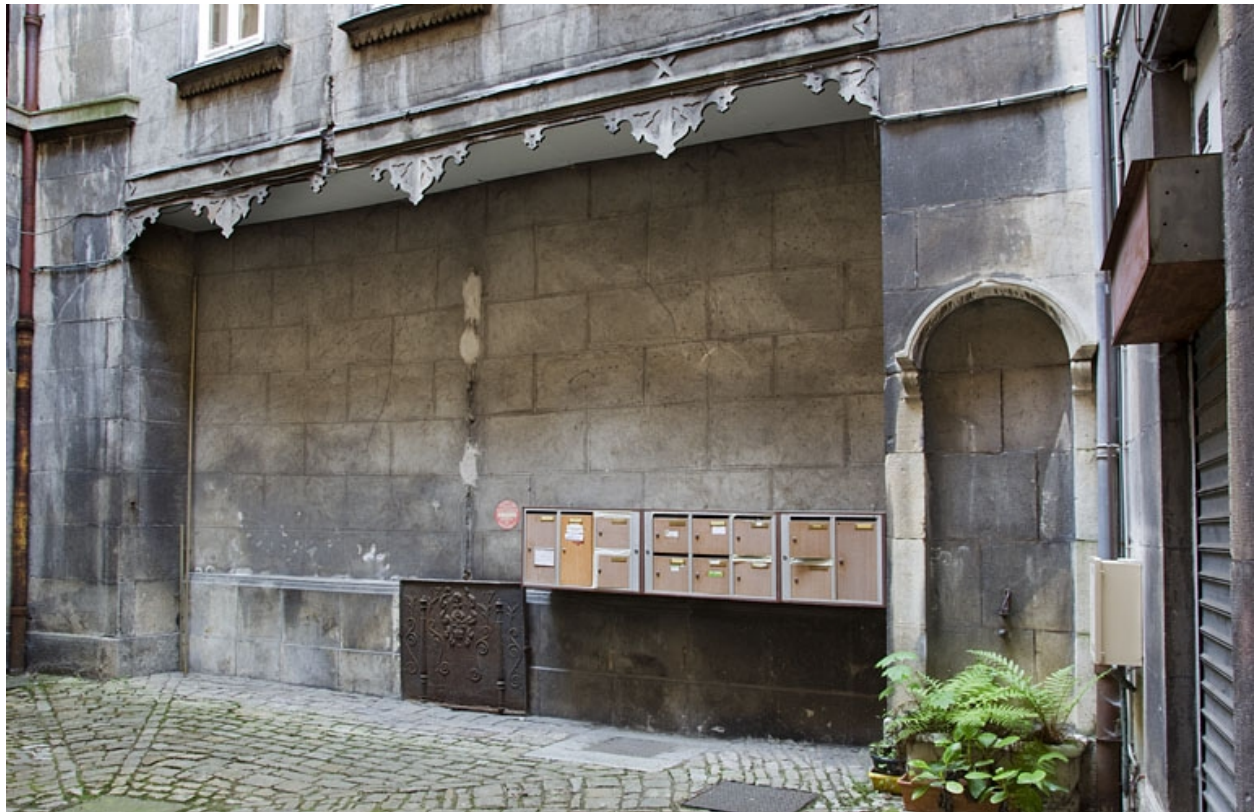
Première cour : vue d'ensemble du puits.
