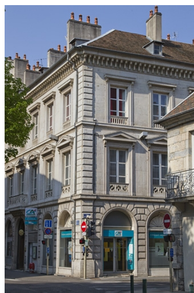
Logis principal : vue de l'angle sur rue.
