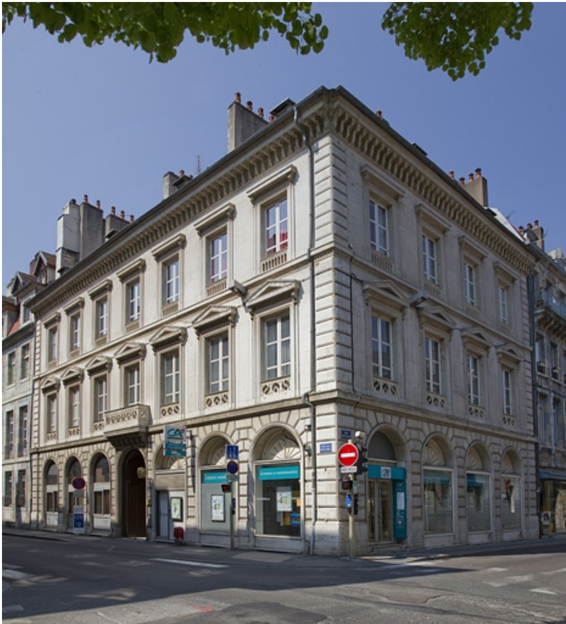
Vue d'ensemble du logis principal.
