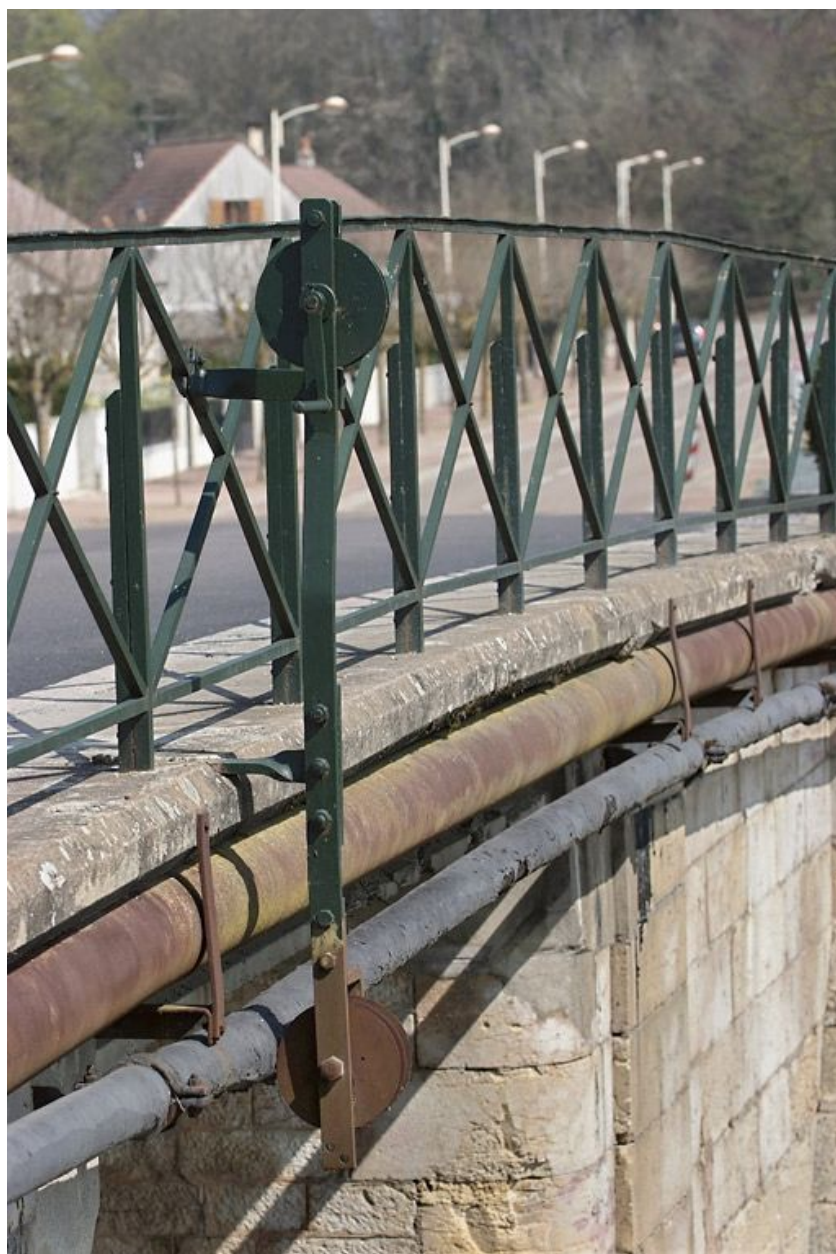
Poulie installée en aval du pont.
