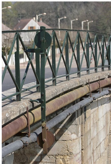
Poulie installée en aval du pont.
