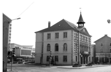
Façades antérieure et latérale droite.
