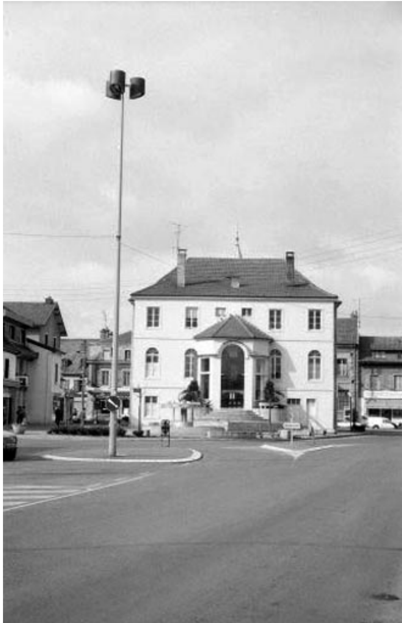
Vue de situation et façade postérieure.
