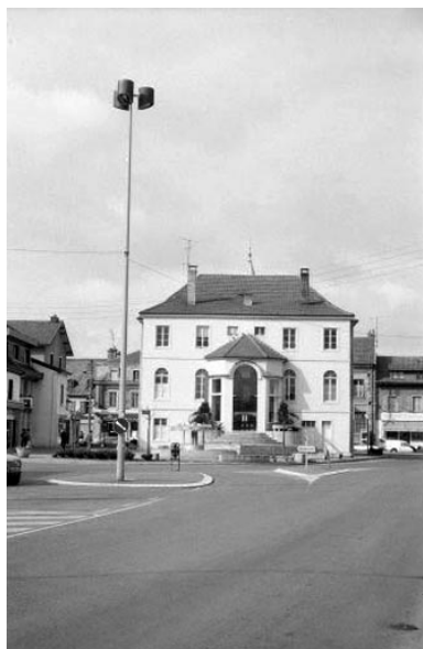
Vue de situation et façade postérieure.
