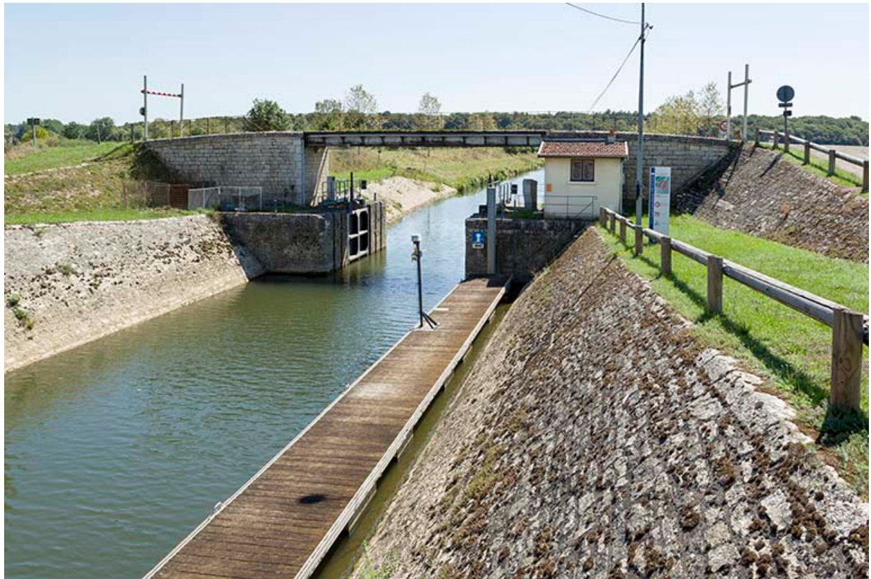
Le sas de l'écluse.
