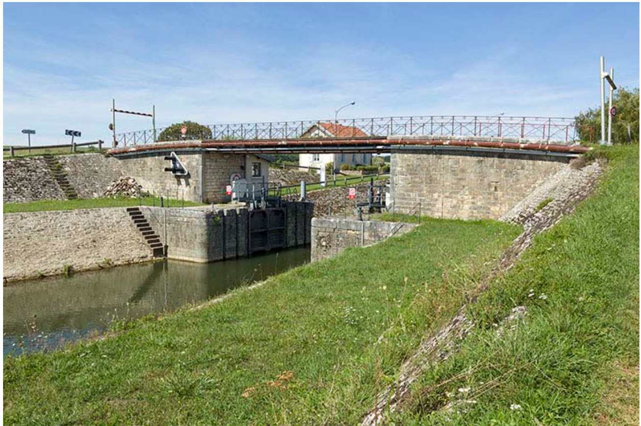
Bief aval de l'écluse.
