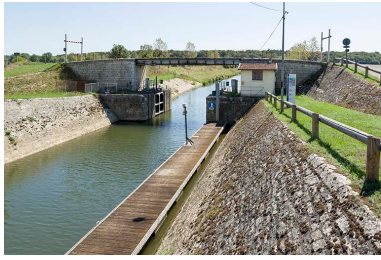
Le sas de l'écluse. Phot. Sonia Dourlot IVR43_20157000808NUC2A
