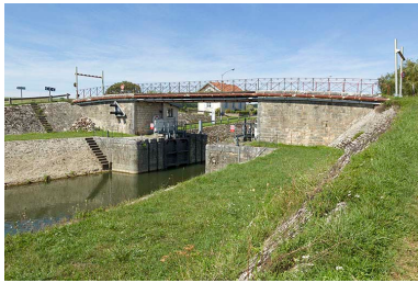
Bief aval de l'écluse. Phot. Sonia Dourlot IVR43_20157000803NUC2A
