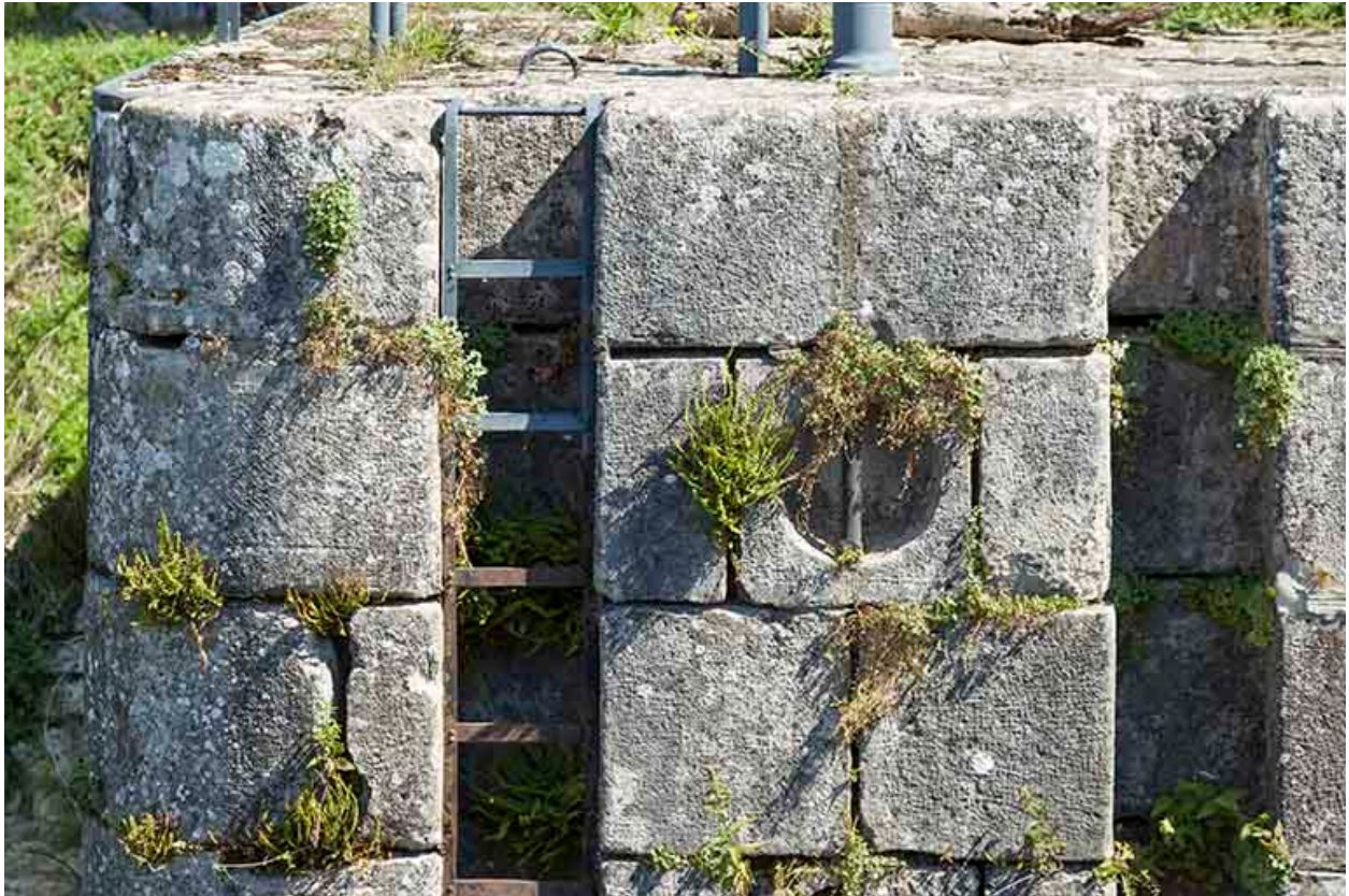
Rainure à batardeau (portière).
