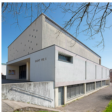
Eglise. Façade antérieure (nord-ouest) et façade sud-ouest. Phot. Aline Thomas IVR43_20212500350NUC4A
