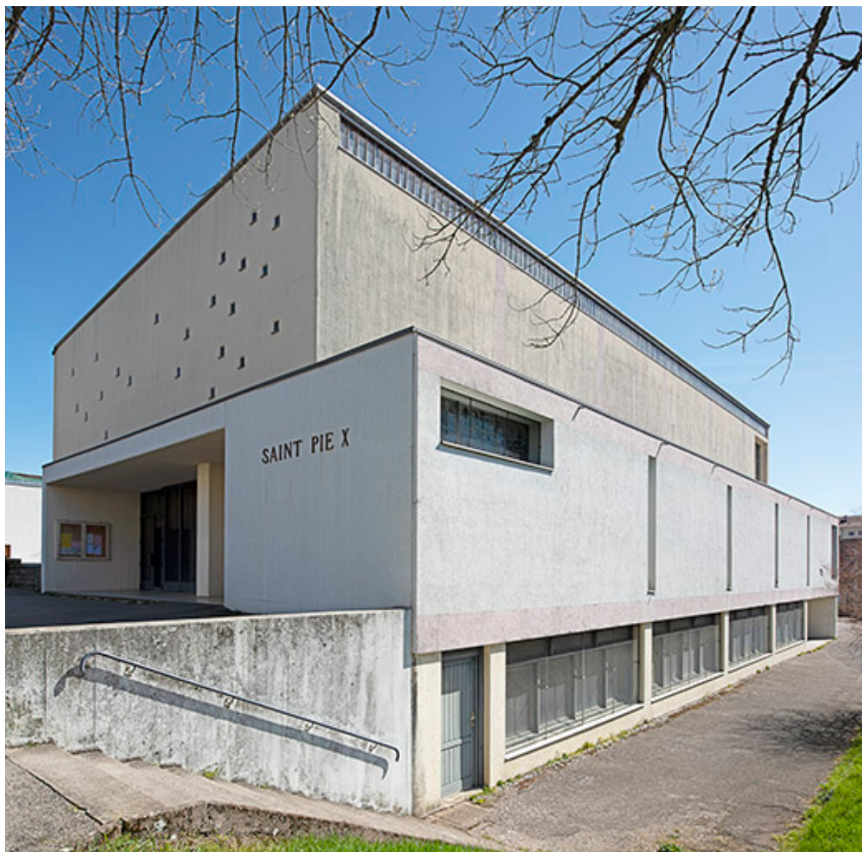
Eglise. Façade antérieure (nord-ouest) et façade sud-ouest.
