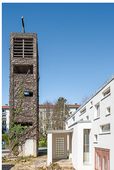
Clocher. Vue de la façade sud-est, à droite l'entrée du presbytère. Phot. Aline Thomas IVR43_20212500346NUC4A
