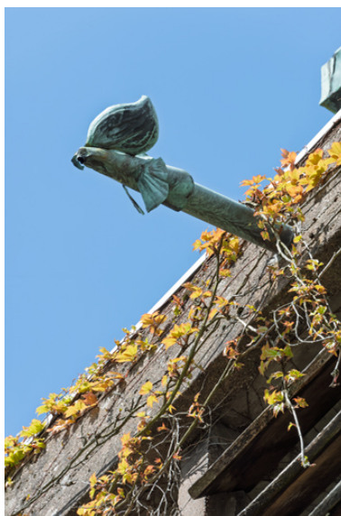
Clocher. Détail de la gargouille. Phot. Pierre-Marie Barbe-Richaud IVR43_20242500128NUC4A
