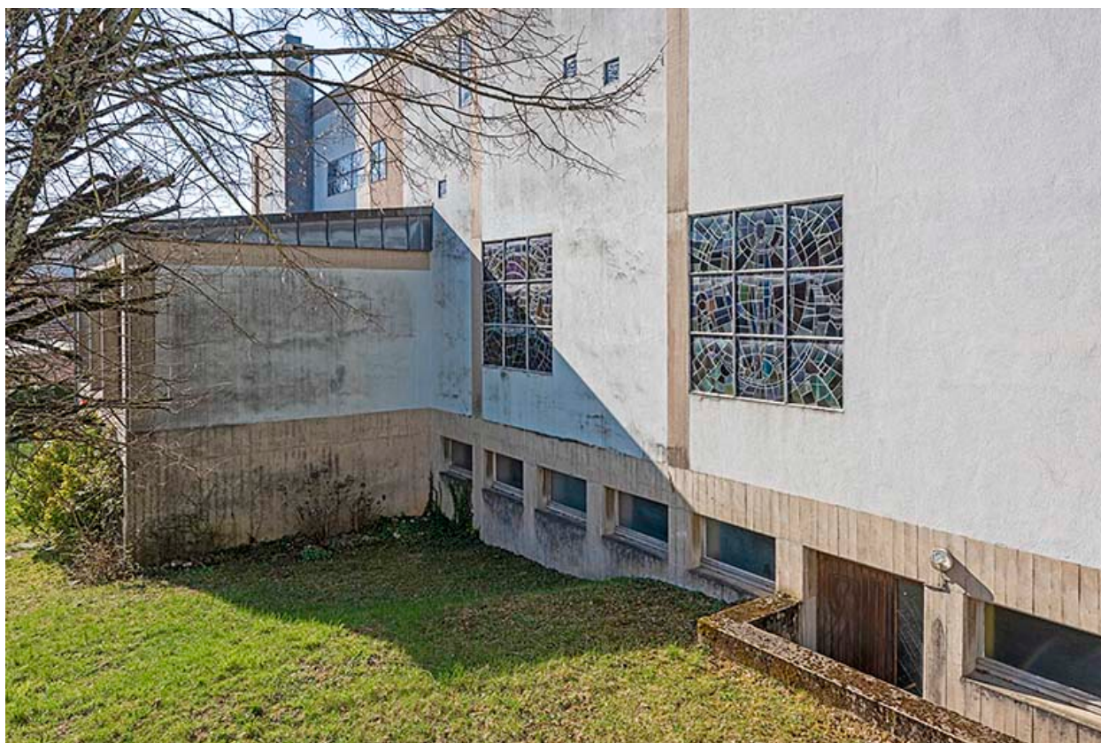
Façade nord-est. Détail.
