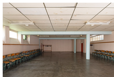
Etage de soubassement. Vue de la grande salle. Phot. Aline Thomas IVR43_20242500215NUC4A
