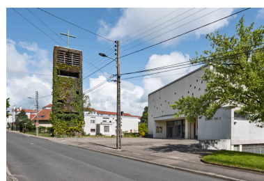
Place-parvis. Vue d'ensemble, de trois quarts. Phot. Pierre-Marie Barbe-Richaud IVR43_20242500124NUC4A
