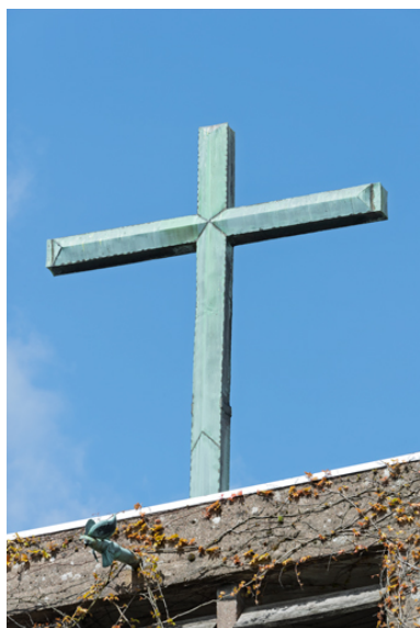
Clocher. Détail de la croix. Phot. Pierre-Marie Barbe-Richaud IVR43_20242500127NUC4A
