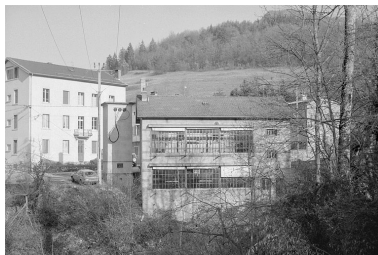
Façade postérieure. Phot. Laurent Poupard IVR43_19913901124Z
