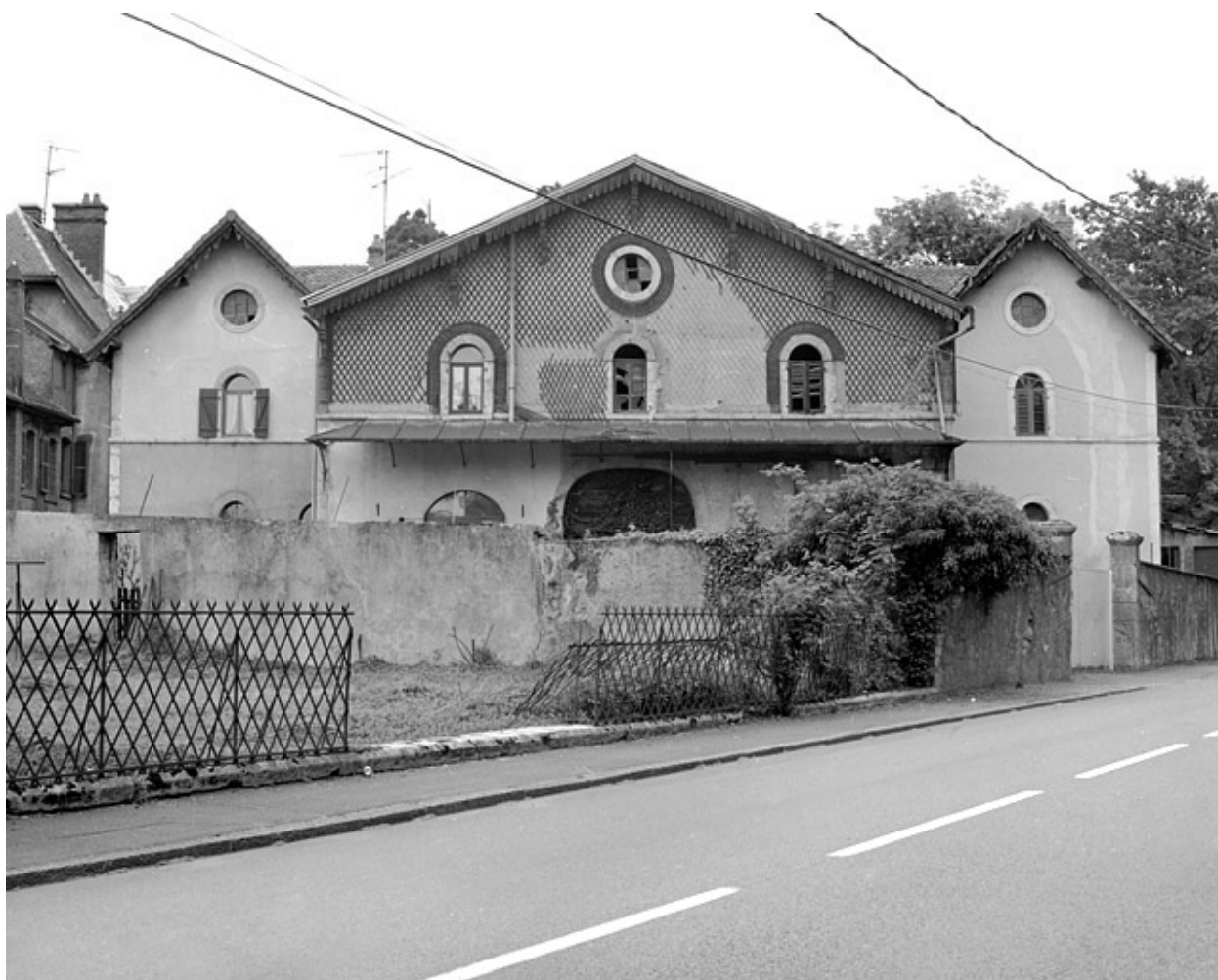
Façade postérieure de la ferme.
