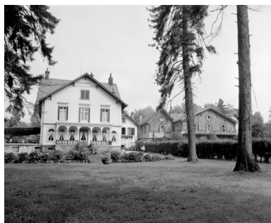
Vue d'ensemble depuis le sud en 1981.SRI. Enquête régionale sur les bâtiments industriels (1979-1981).
