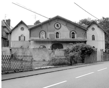
Façade postérieure de la ferme.
