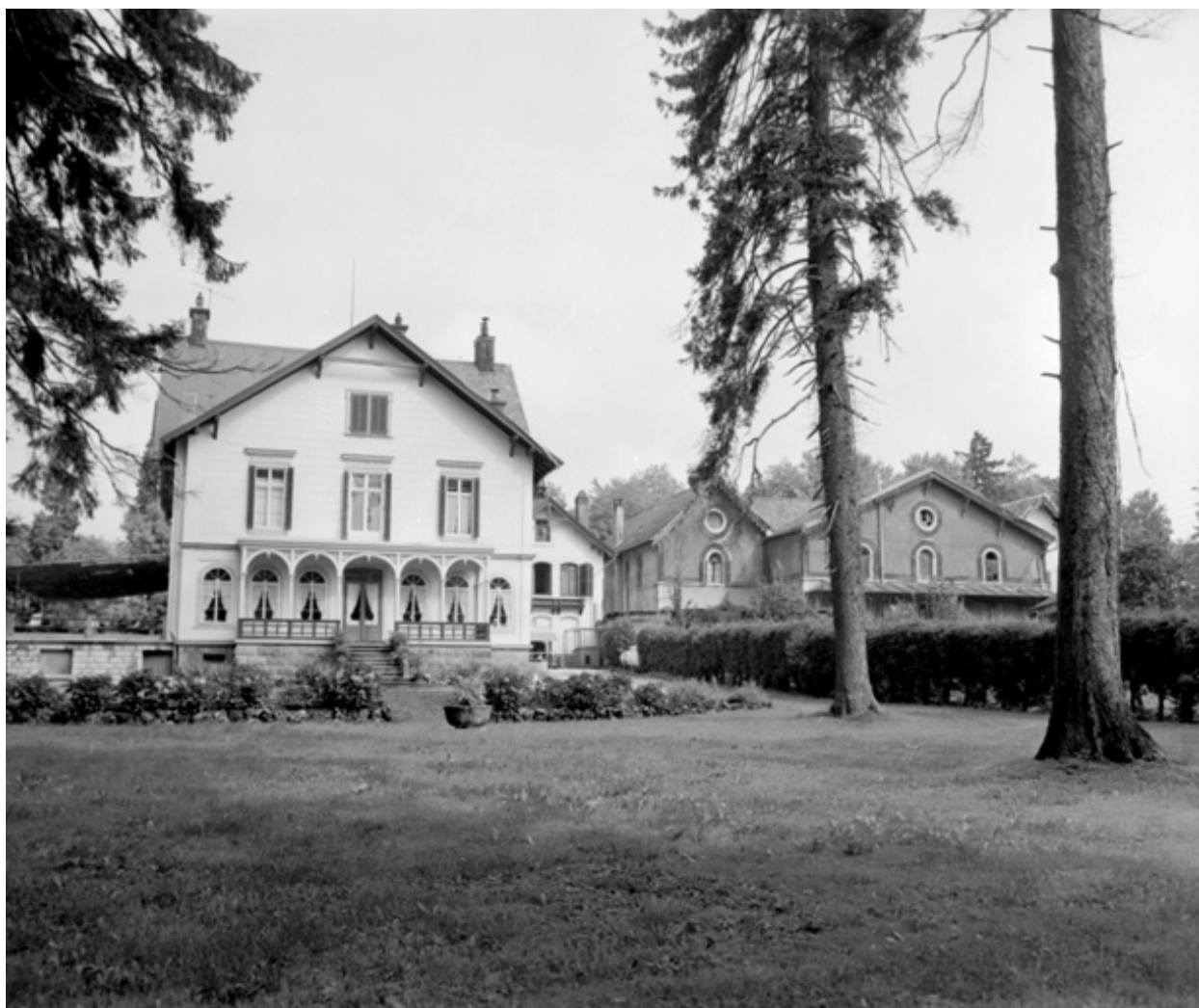
Vue d'ensemble depuis le sud en 1981.SRI. Enquête régionale sur les bâtiments industriels (1979-1981).
