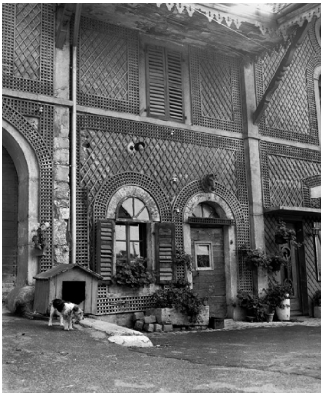
Façade antérieure de la ferme : partie centrale (logement) en 1981.SRI. Enquête régionale sur les bâtiments industriels (1979-1981).
