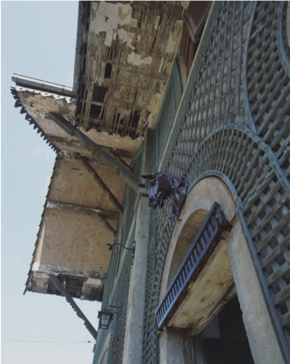
Façade antérieure de la ferme. Détail du décor.
