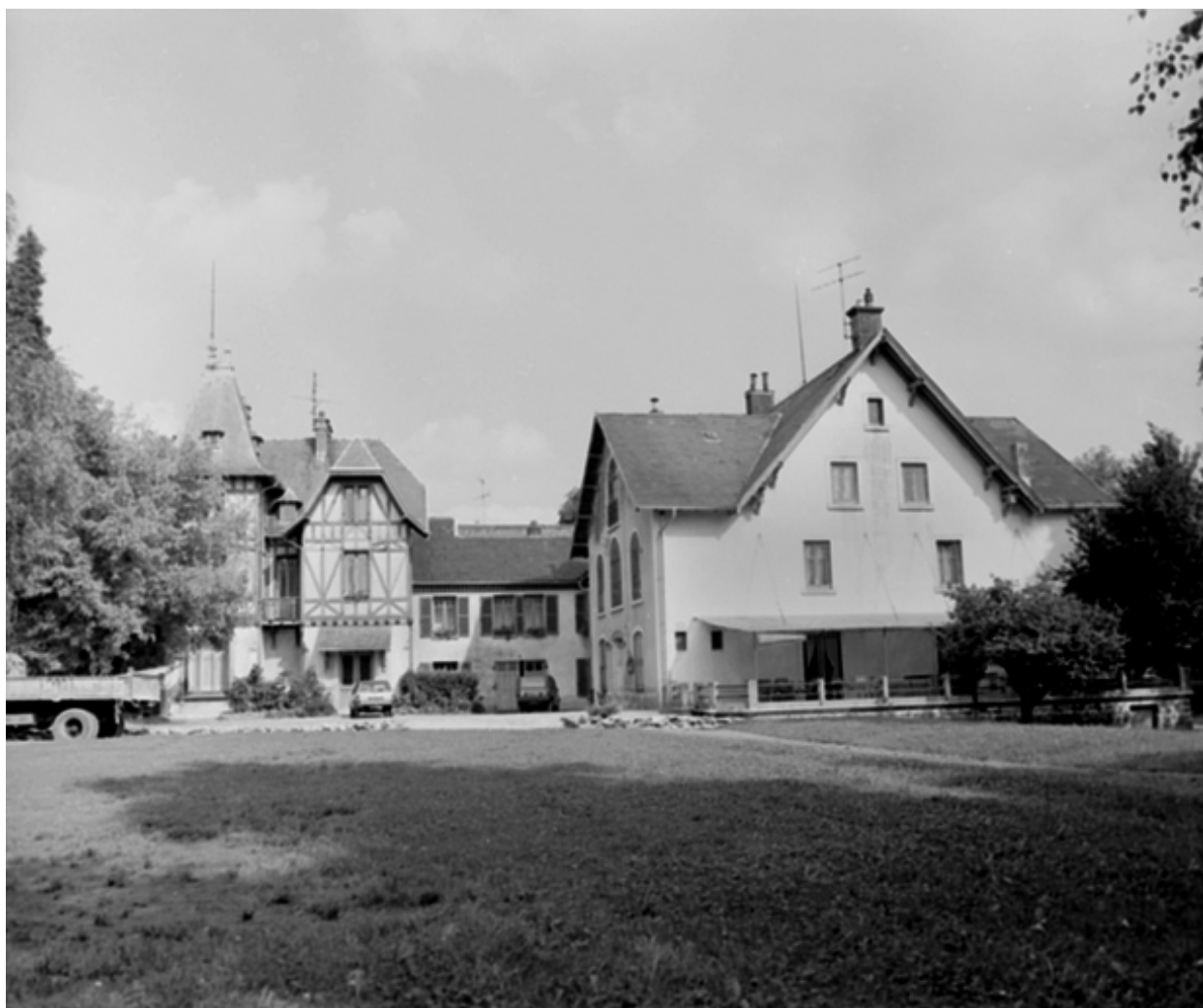
Vue d'ensemble depuis l'ouest en 1981.SRI. Enquête régionale sur les bâtiments industriels (1979-1981).
