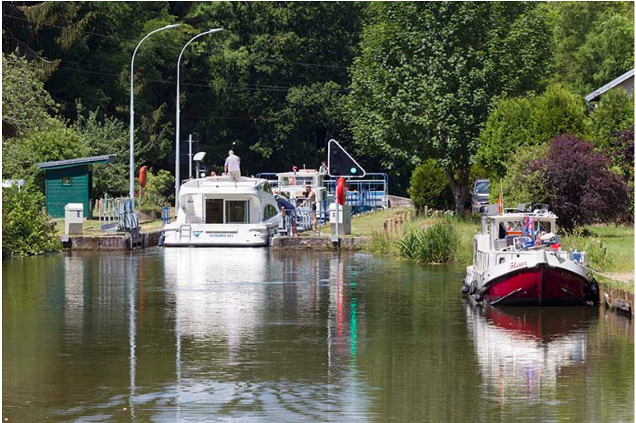
Vue d'ensemble du site d'écluse depuis l'amont avec la gare d'eau au premier plan.
