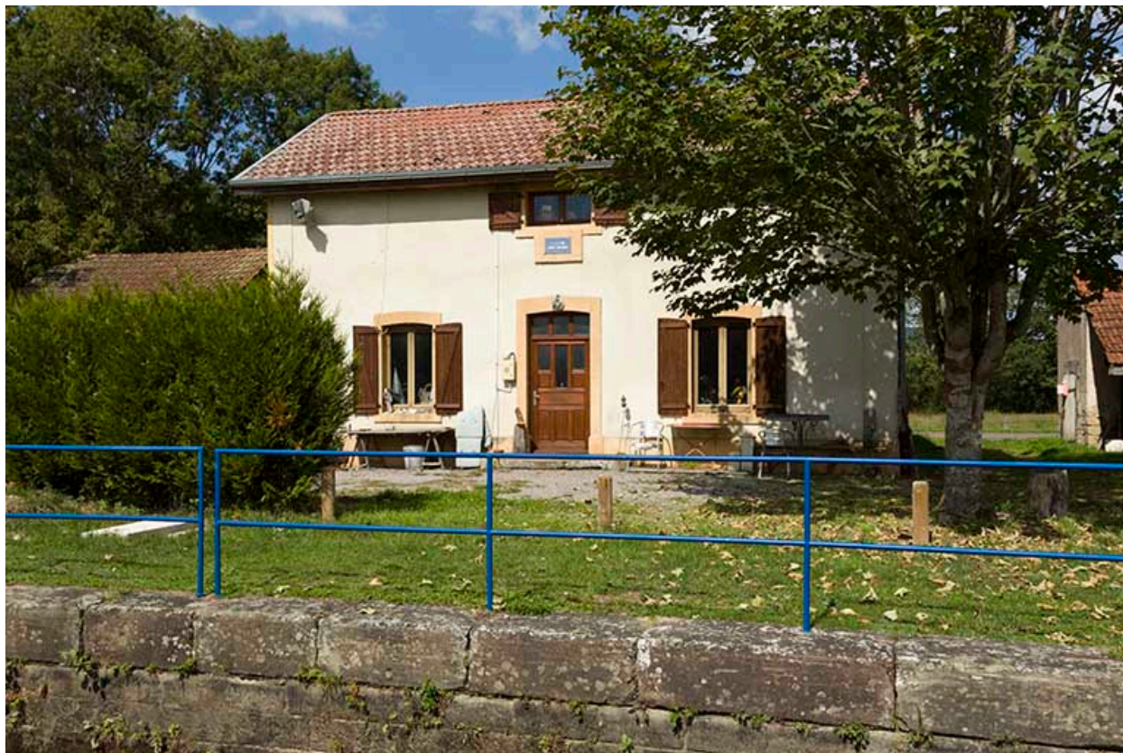
La maison d'éclusier, depuis l'écluse.
