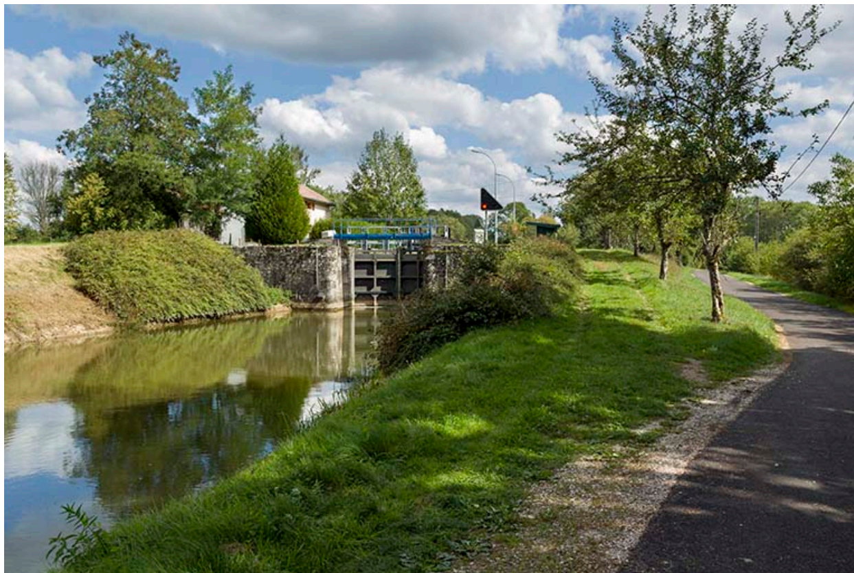
Vue d'ensemble depuis l'aval avec l'ancien chemin de halage transformé en voie cyclable.
