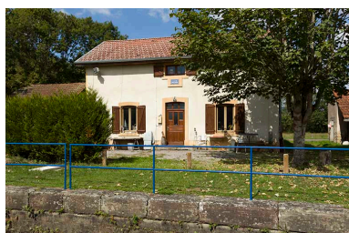
La maison d'éclusier, depuis l'écluse. Phot. Sonia Dourlot IVR43_20157000905NUC2A
