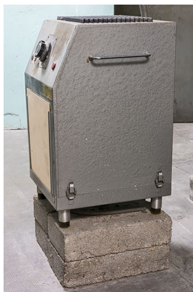
Redresseur Sofalec (projecteur côté jardin). Phot. Pierre-Marie Barbe-Richaud IVR26_20222100054NUC4A
