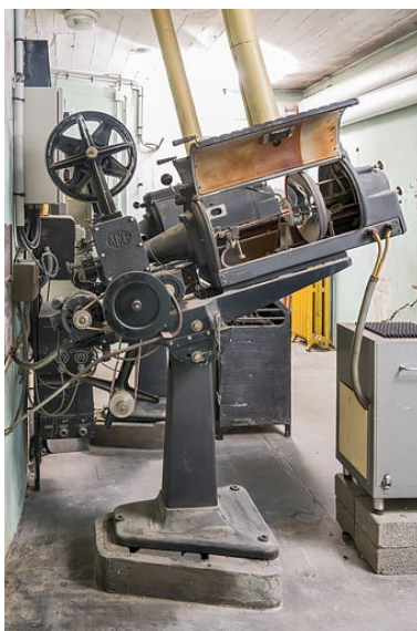
Projecteur côté jardin (volets de la lanterne ouverts). Phot. Pierre-Marie Barbe-Richaud IVR26_20222100045NUC4A
