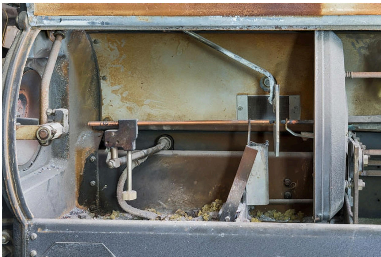
Projecteur côté jardin, lanterne : lampe à arc, en position d'arrêt.
