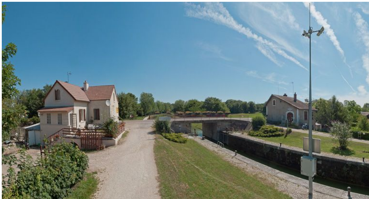
Vue d'ensemble du site d'écluse.
