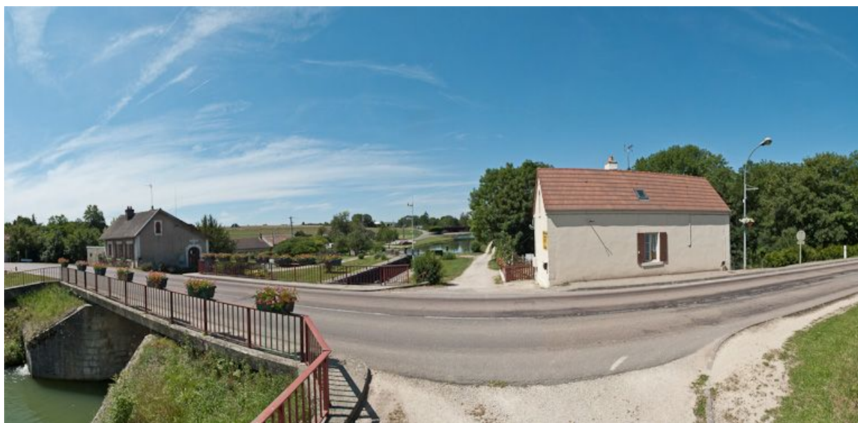
Vue d'ensemble du site d'écluse.
