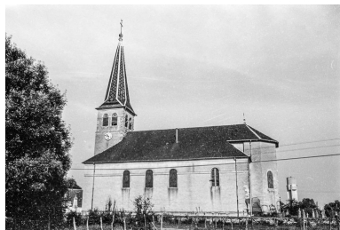
Face latérale droite. Phot. Guy Forestier IVR43_19753900257Z
