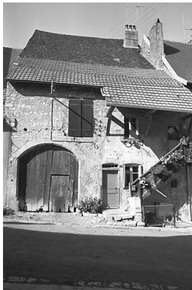
Façade sur rue. Phot. Bernard Lardière IVR43_19797000397Z
