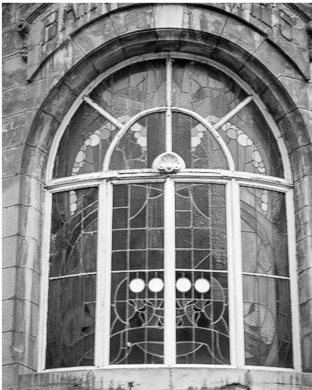
Baie cintrée vue de l'extérieur.
