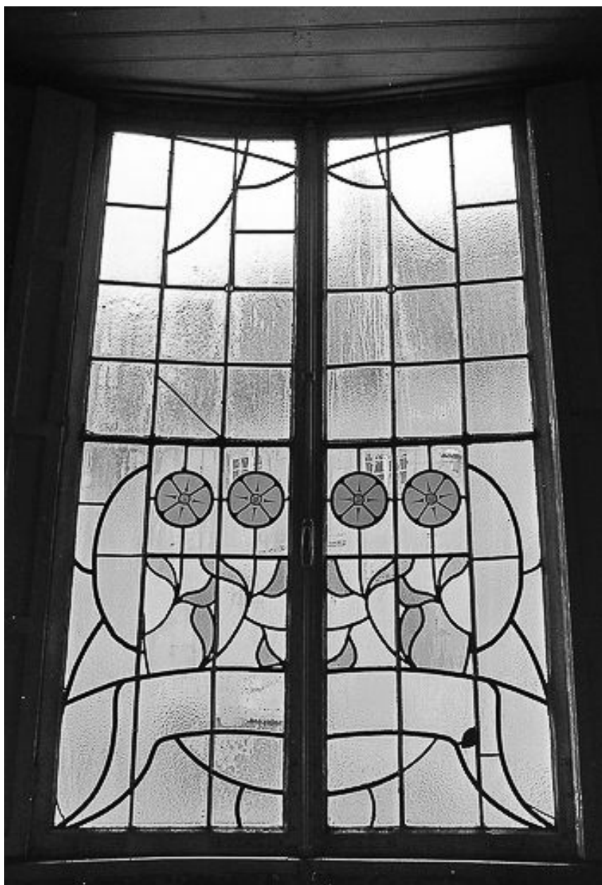
Baie cintrée vue de l'intérieur.
