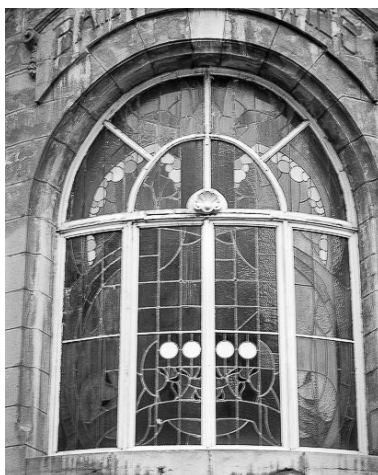
Baie cintrée vue de l'extérieur. Phot. Jean-Luc Ligier IVR43_19822500106X
