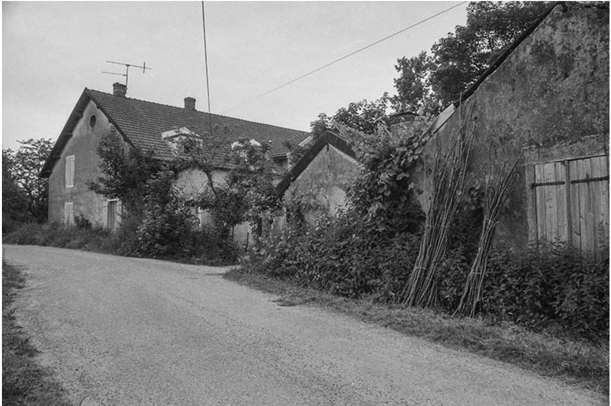
Vue d'ensemble depuis le chemin.
